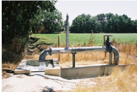
**Figure 6 : Photo de la vanne alimentant le canal d'amenée sur la parcelle 1J**
