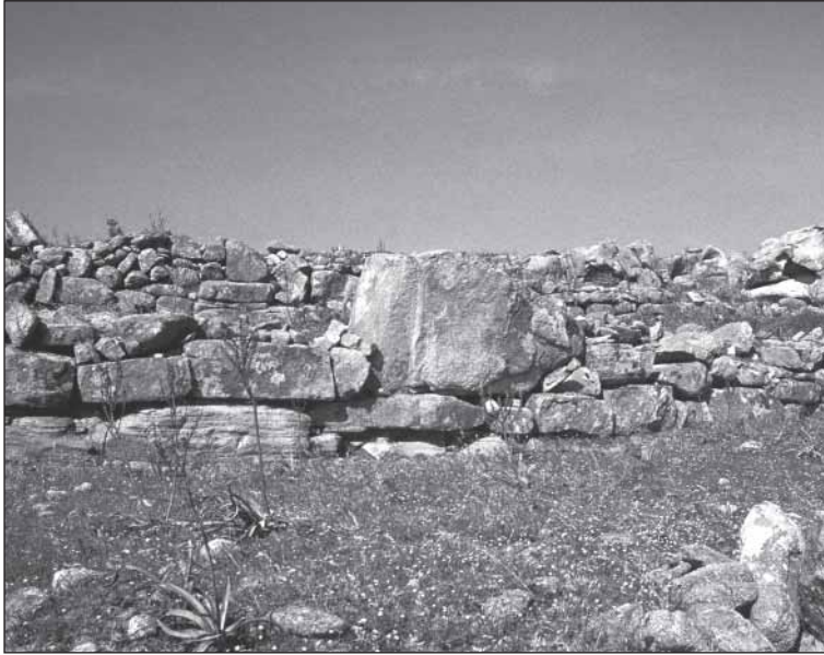
■ Photo 1 Parement intérieur d'une terrasse.
