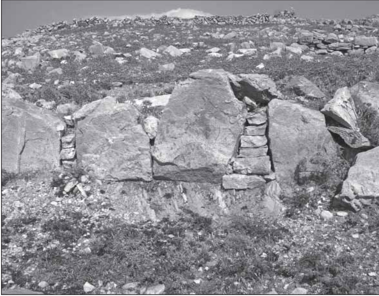
■ Photo 2 Parement extérieur d'une terrasse.
