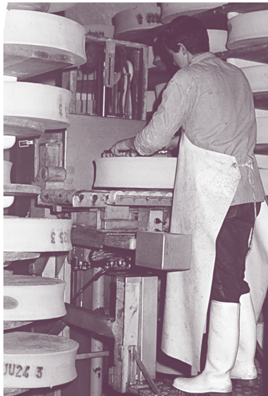
Machine à soigner le Beaufort (brevet INRA).
