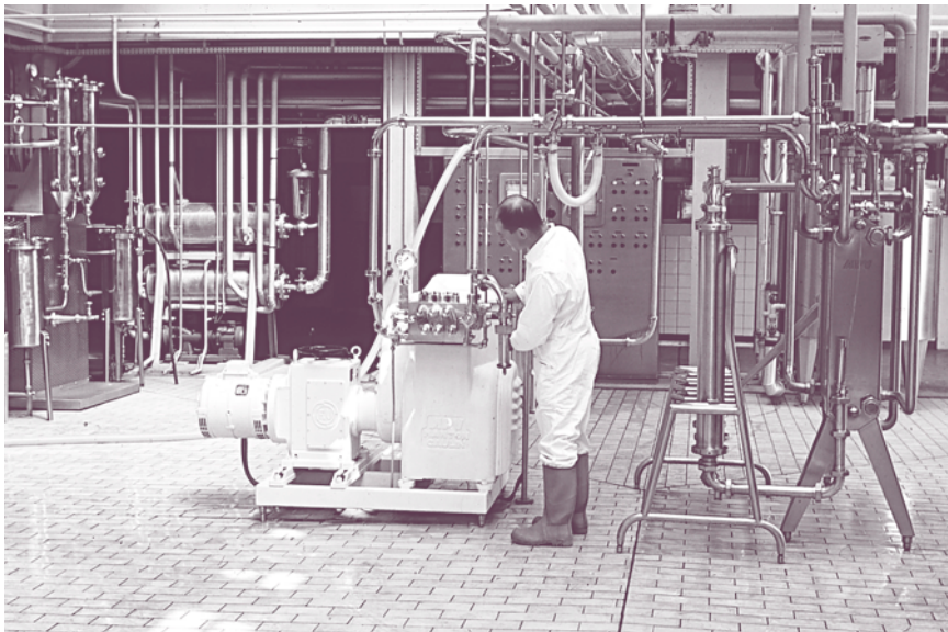
L'installation de traitement du lait. INRA Jouy-en-Josas.
