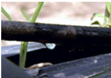
Goutte à goutte
