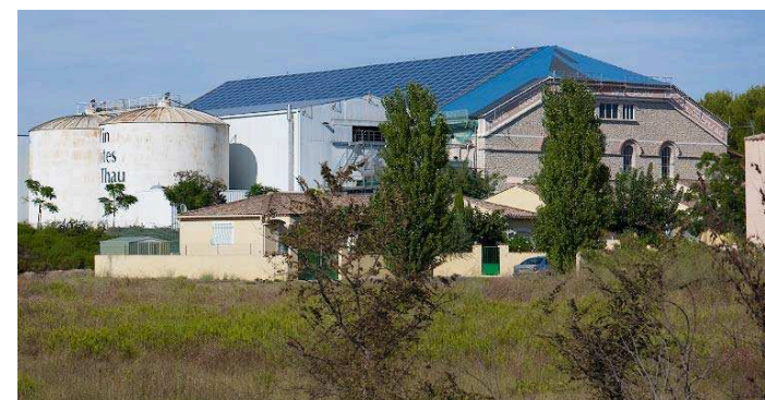
fig. 266 – Cave coopérative de Florensac (34). Couverture photovoltaïque installée en 2009 sur la cave construite par Brès en 1934.
