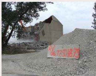
fig. 267 — Cave coopérative de Dions (30) : Saint-Père, architecte, 1929. Démolition de la cave en 2008 (photo. J.-L. Vayssettes).
