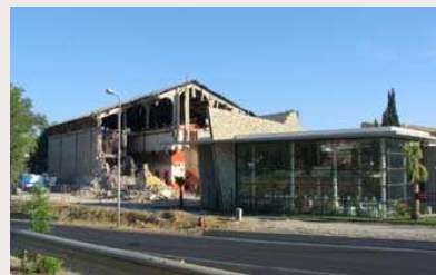
fig. 269 — La cave de Celleneuve en cours de démolition. Seul le caveau moderne (à droite) sera conservé (photo. F. Mazerand).
