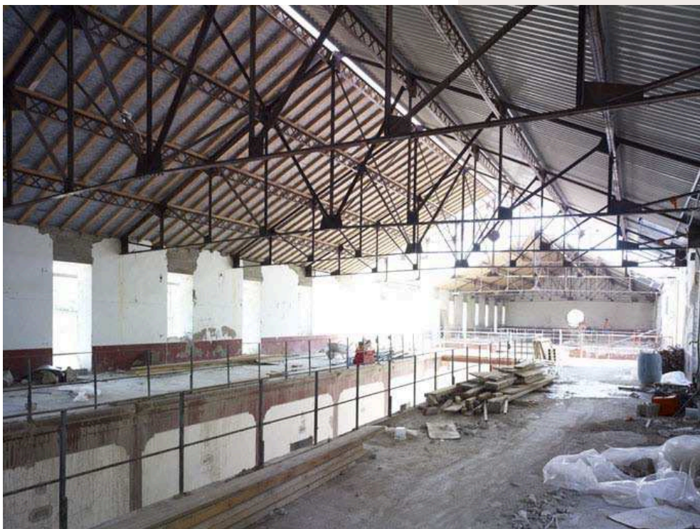
fig. 272 — Ancienne cave coopérative de Bélesta (66) en cours de réhabilitation.
