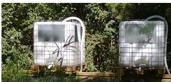
Figure 1 : Mise en place des cuves de stockage pour le prélèvement d'eaux usées brutes
