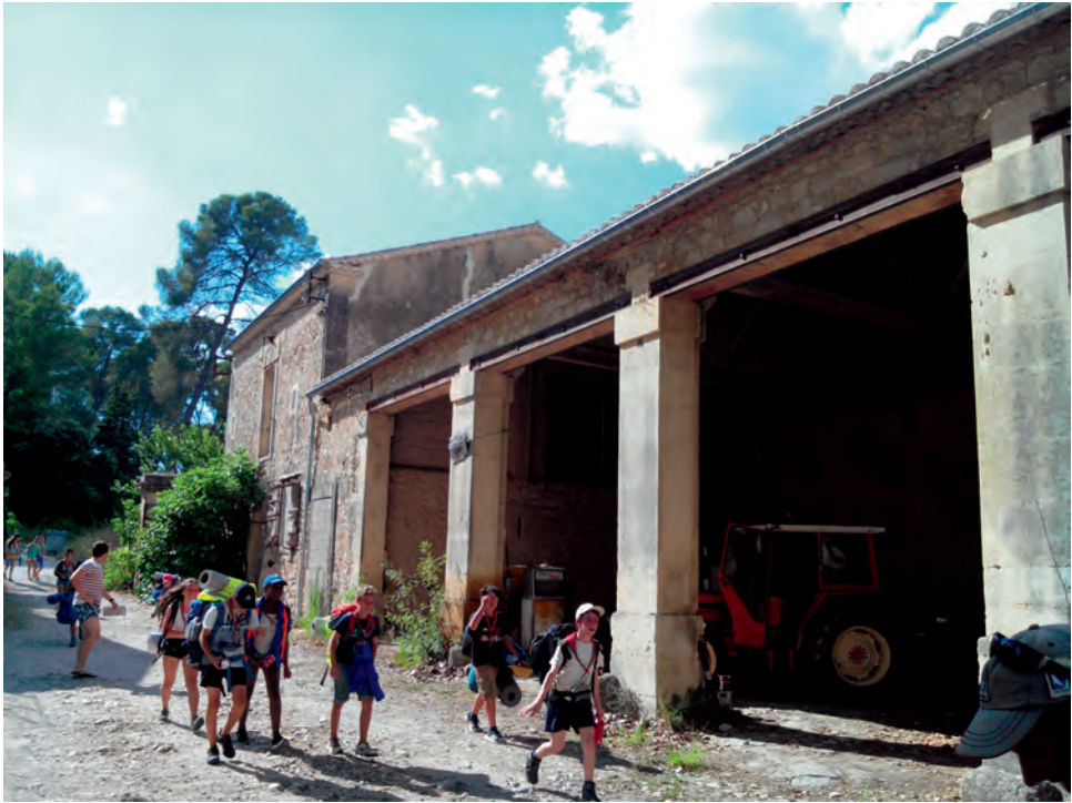
Les vieux bâtiments du domaine de Viviers. Une partie est à l'abandon, une partie est prêtée à l'espace test agricole pour stocker du matériel (cl. N. Hasnaoui Amri 2016)
