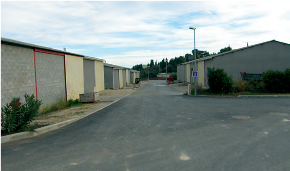
Photo 1. Vue du 1 er regroupement de hangars agricoles à Saint-Geniès des Mourgues. Ils sont organisés autour d'une allée centrale qui facilite l'entraide et le dialogue (cl. B. Nougarèdes 2007)
