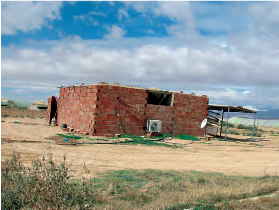
Habitation d'ouvriers agricoles travaillant dans les périmètres irrigués, commune d'El Ghrous, wilaya de Biskra (cl. J.-P. Colin 2014)
