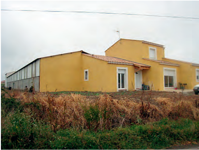
Photo 4. Vue des logements adossés aux hangars de viticulteurs à Florensac (cl. C. Champigneule 2010) On voit les hangars à l'arrière. Plusieurs logements ont ainsi été adossés au bout des barres de hangars
