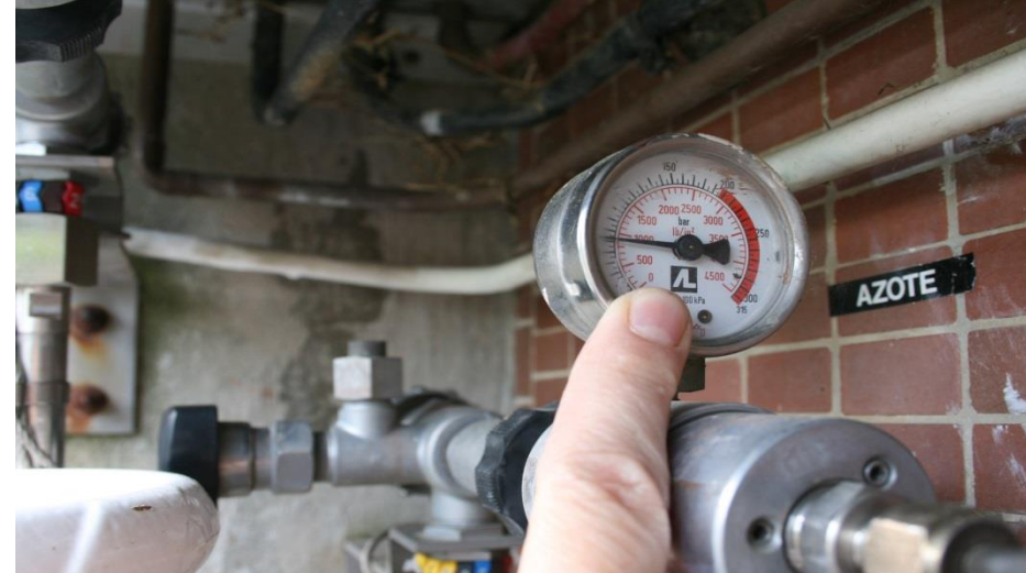
Ouverture de la bouteille mis en pression control manomètre
