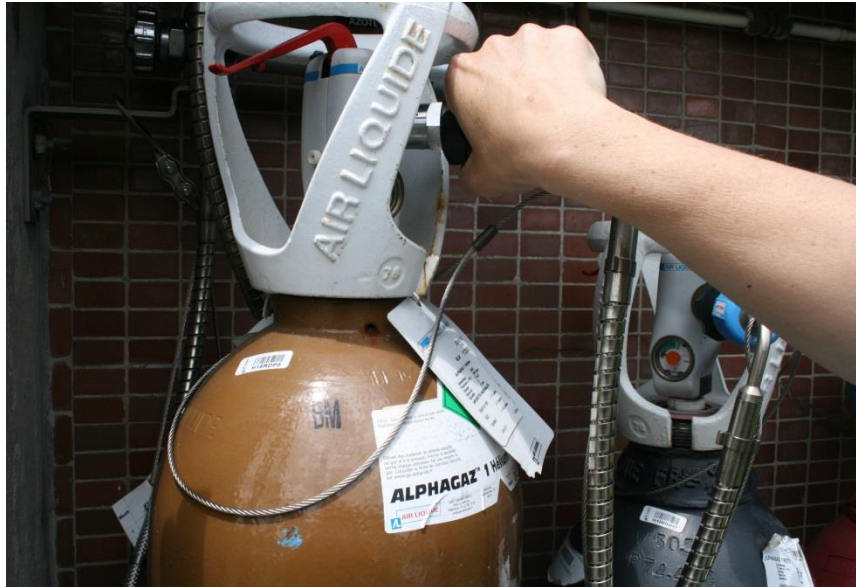
Installation du flexible d'alimentation et ouverture de la bouteille neuve
