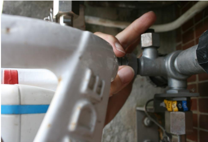
Fermeture de la purge et ouverture du circuit
