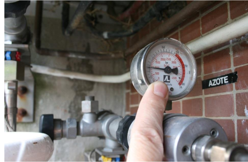
Control du niveau de gaz sur la bouteille et sur le détendeur
