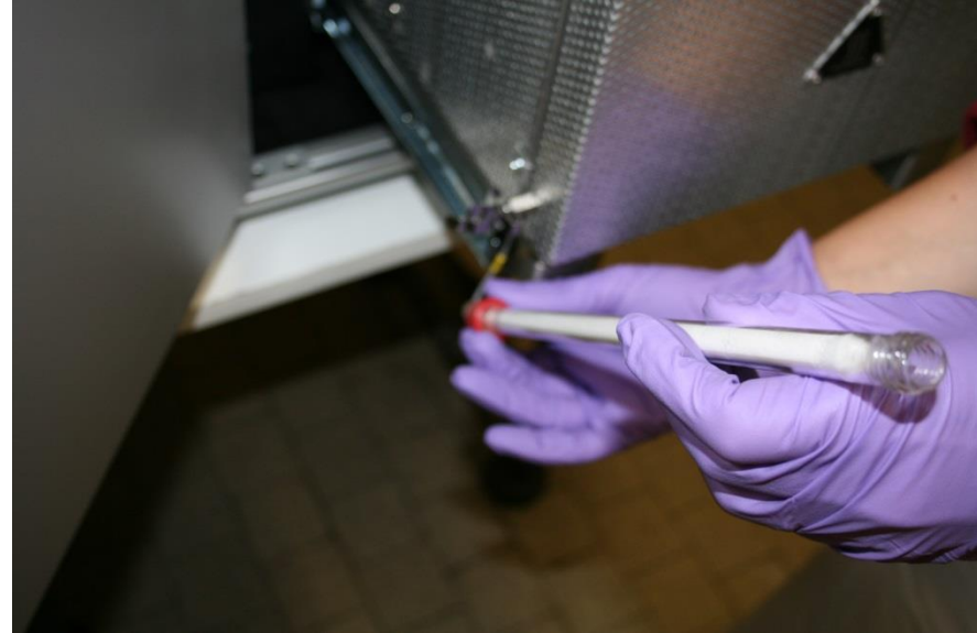
Control de la présence du joint vert et fixation du connecteur
