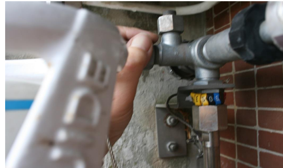
Fermeture de la bouteille et ouverture de la purge
