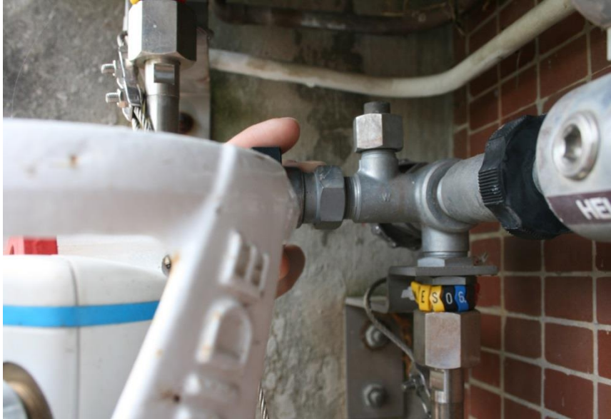
Ouverture et fermeture de la vanne de purge et ensuite retrait du flexible d'alimentation
