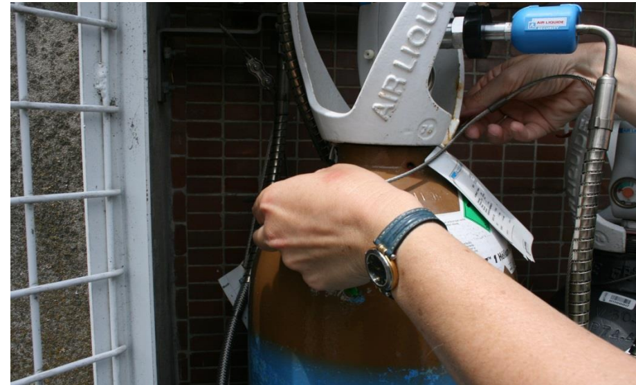
Dépose du câble de sécurité, nouvelle bouteille retrait bouchon obturateur bleu et repose câble
