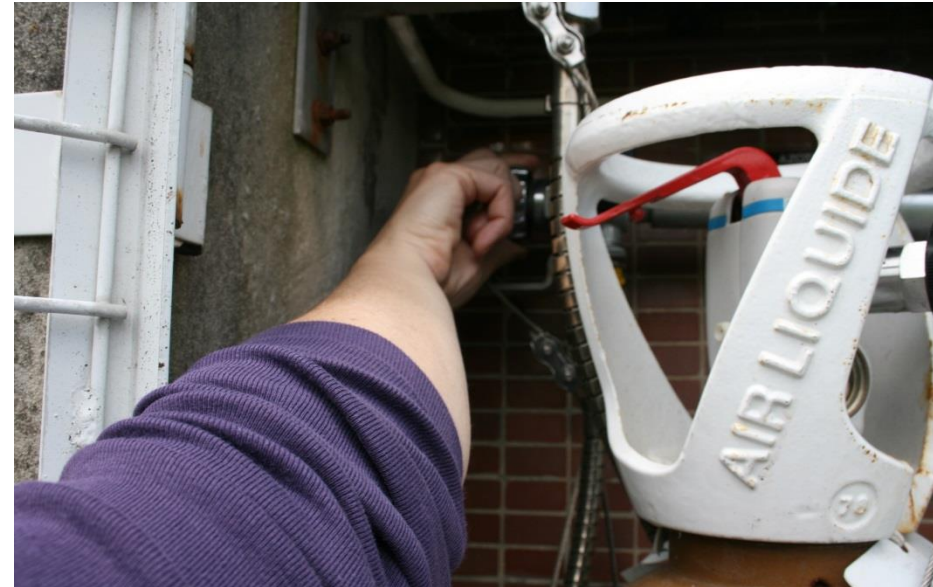
Fermeture de la purge et ouverture du circuit
