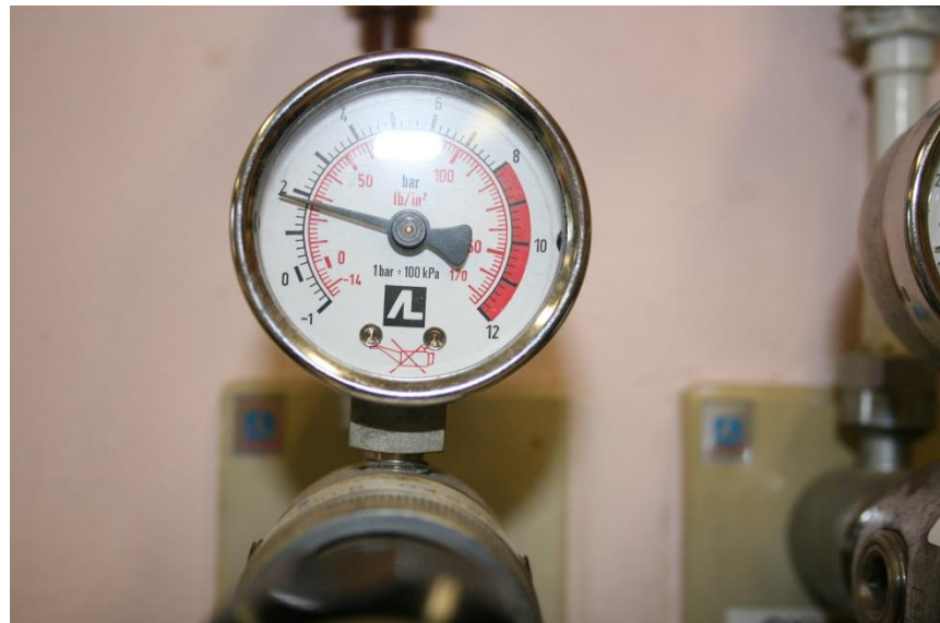
Pression d'hélium ajusté a 1,8bar(1250mbar)
