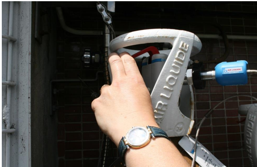
Fermeture de la bouteille et ouverture de la purge
