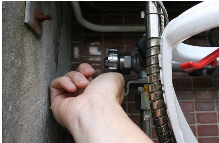
Fermeture du gaz au niveau de la bouteille puis au niveau du circuit
