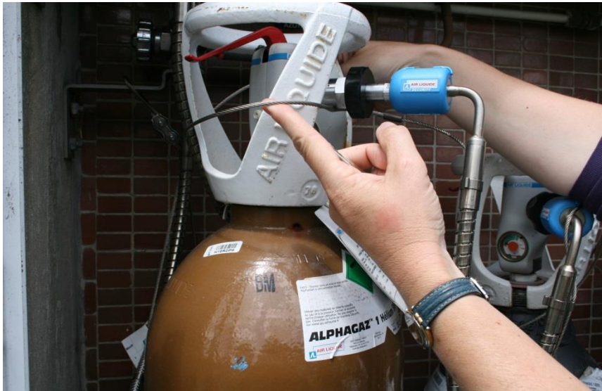
Dépose du câble de sécurité, nouvelle bouteille retrait bouchon obturateur bleu et repose câble
