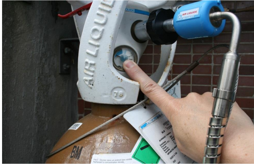
Control du niveau de gaz sur la bouteille et sur le détendeur
