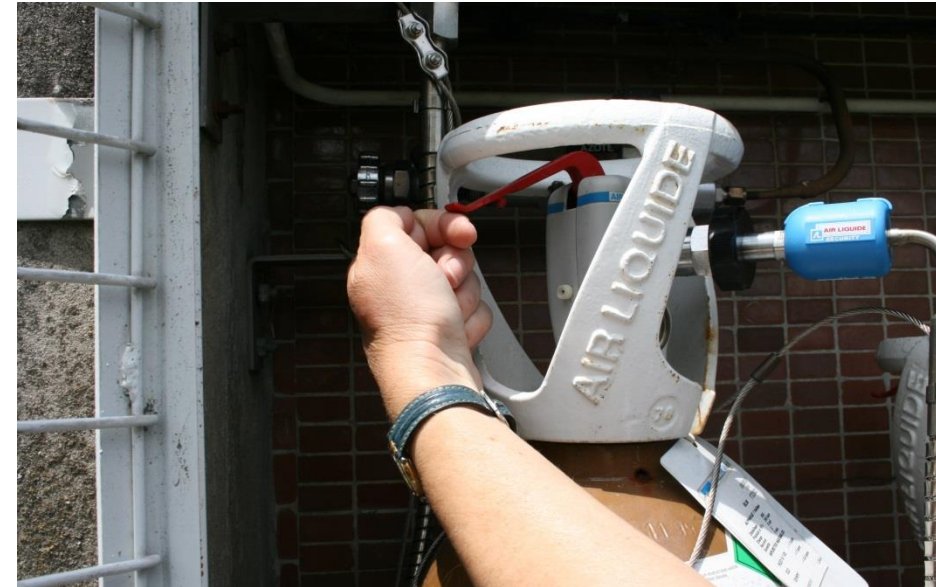
Installation du flexible d'alimentation et ouverture de la bouteille neuve
