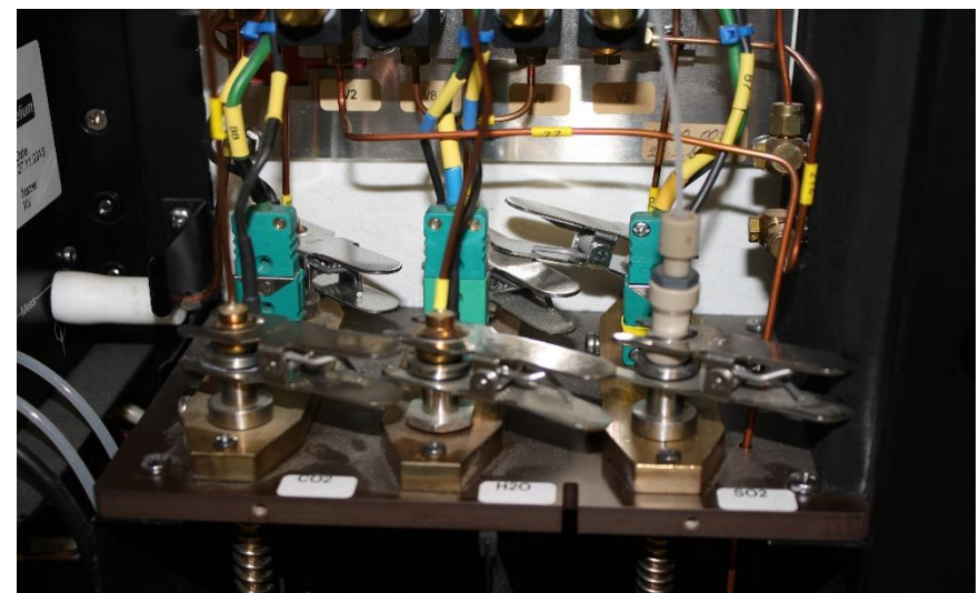
Retrait de la bille sur la ligne SO 2 et installation du tubing attention aux joints noir
