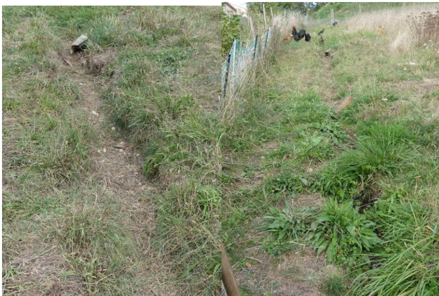
Photographies 8 : Site 2, aspect général du filtre.
