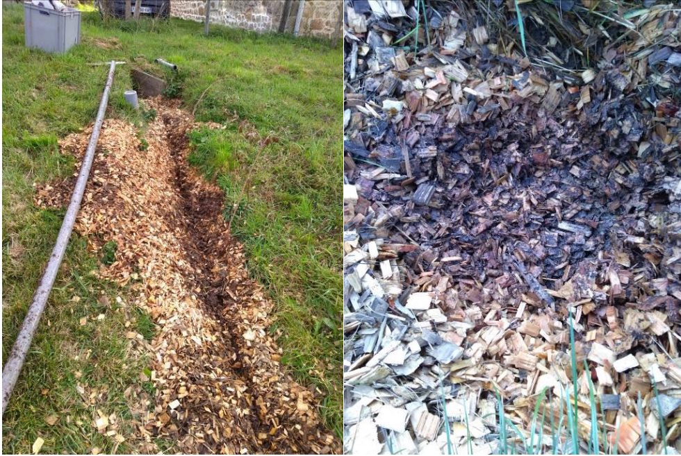
Photographies 16 : Site 5, aspect du filtre.
