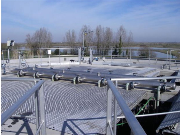
Figure 7 : Réacteurs membranaires couverts et vue de dessus
