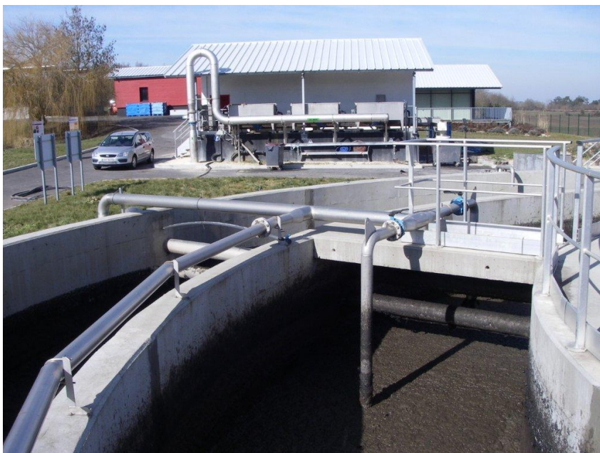
Figure 6 : Bassin d'aération
