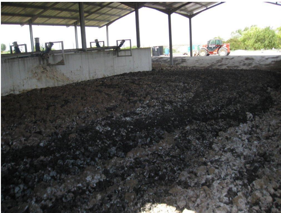
Figure 12 : Aire de stockage couverte
