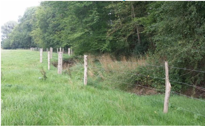
Cliché 12 : Berge gauche, le cours d'eau érode le sol sous la clôture
