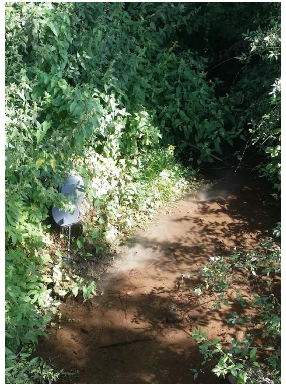
Cliché 24 : Point de pollution 3, écoulement observé au niveau du surpresseur lors de l'exploration. Le problème à été rapidement réglé
