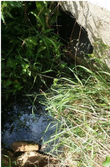
Cliché 25 : Point de pollution 4, l'écoulement continu provenant de l'exutoire indique que cette pollution est permanente
