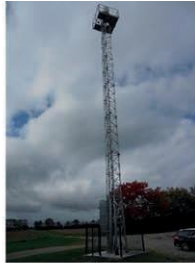
Montoldre Centre de recherche Irstea Hauteur d'émission : 22 mètres Portée : 72 km
