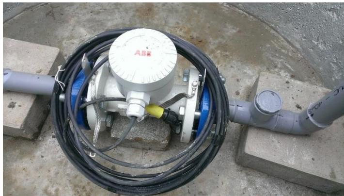
Débitmètre électromagnétique ABB AquaMaster 3 DN40
