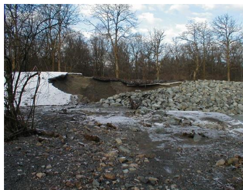
Figure 10.1 : Brèche partielle par érosion interne (Photo : Cyril Folton / Patrice Mériaux) (à gauche) et Brèche partielle par surverse (Photo : Patrice Mériaux / Paul Royet) (à droite)
