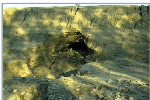
Figure 10.1 : Brèche partielle par érosion interne (Photo : Cyril Folton / Patrice Mériaux) (à gauche) et Brèche partielle par surverse (Photo : Patrice Mériaux / Paul Royet) (à droite)
