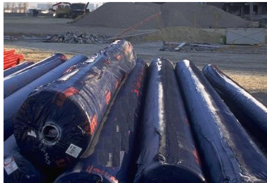
Figure 4.23 : Exemple de stockage de rouleaux de géosynthétiques (Crédit photo : Tencate Geosynthetics)
