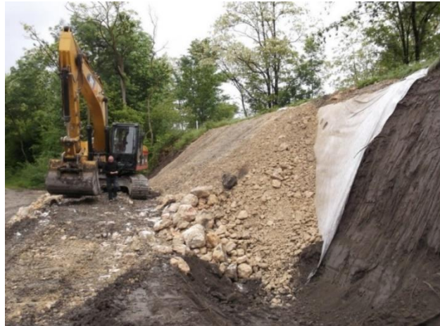
Figure 9.8 : Mise en place d'un remblai drainant en 0/400mm (déchet de carrière) sur interface géotextile. Chantier Digue Isère aval à Noyarey (38) (Crédit Photo : SYMBHI)
