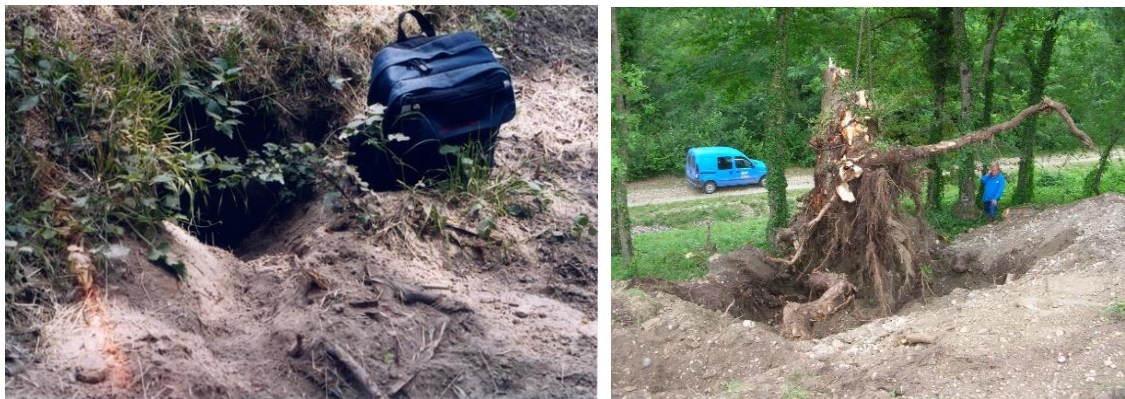
Figure 9.1 : Trou de terrier de blaireau à gauche (photo R. Tourment) et déchargement d'une souche de peuplier noir à Cusset (03) à droite [9-1]
