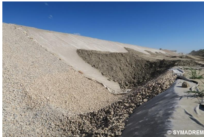
Figure 4.13 : Photographie d'un chantier de recharge drainée (Crédit Photo : Symadrem)
