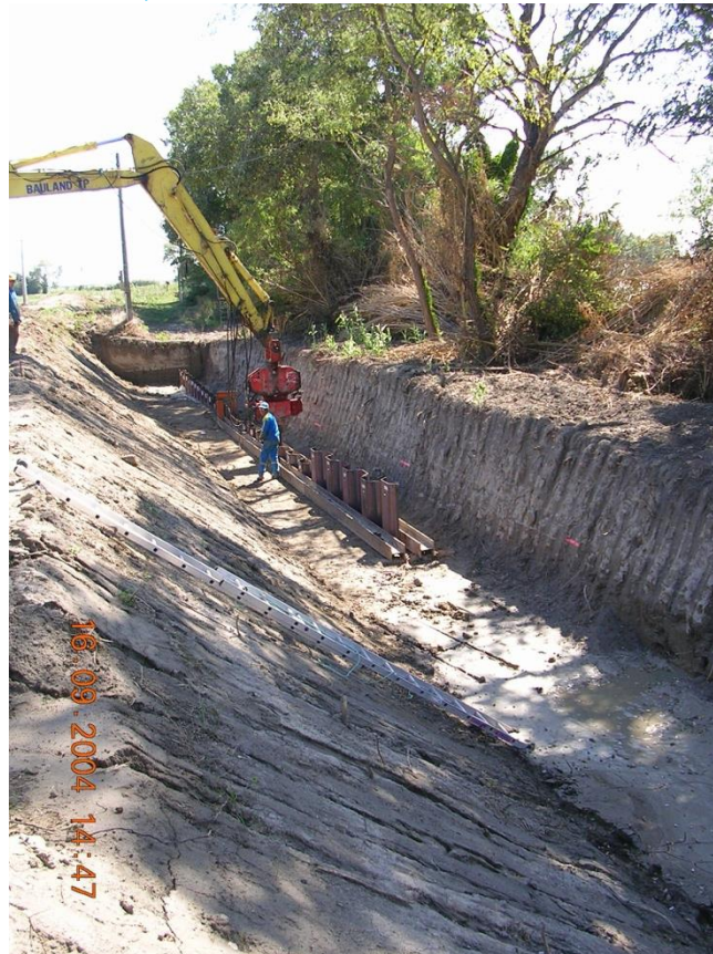
Figure 3.4 : Réalisation d'un rideau de palplanches pour étanchéité en fondation côté eau d'une digue, destiné à être surmonté d'un remblai argileux pour étanchéité du corps de digue (Photo : R. Tourment)
