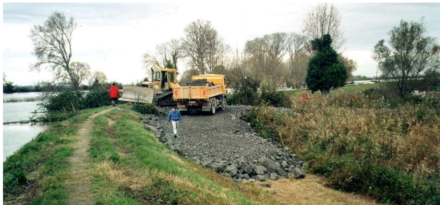
Figure D.3 : Intervention d'urgence en 2002 (crédit photo : SYMADREM)
