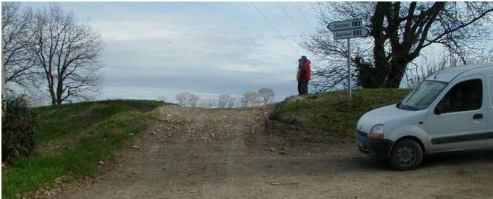
Figure D.10 : Intervention sur encoule suite à début de surverse (Crédit photo : SYMADREM)
