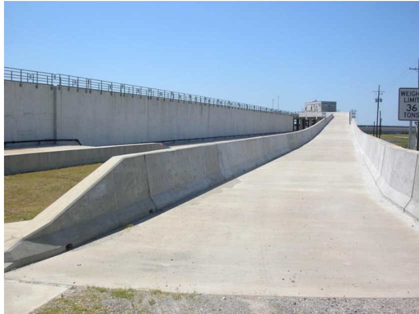
Mur anti-inondations à gauche (et passerelle de franchissement pour les véhicules) à la Nouvelle-Orléans – États-Unis (crédit photo : Rémy Tourment)
