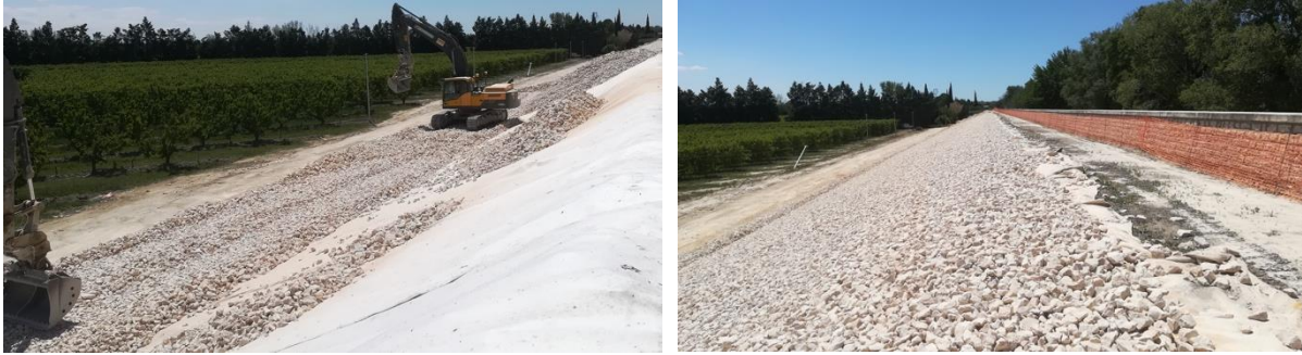
Figure 4.11 : Photographies illustrant la technique de recharge drainante (Crédit Photo : Symadrem)
