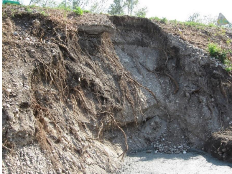
Figure 9.5 : Photographie d'un abattage définitif avec extraction complète de la souche au droit du terrain naturel (Crédit photo : ADIDR – 2009 – Drac RG – Fontaine (38))
