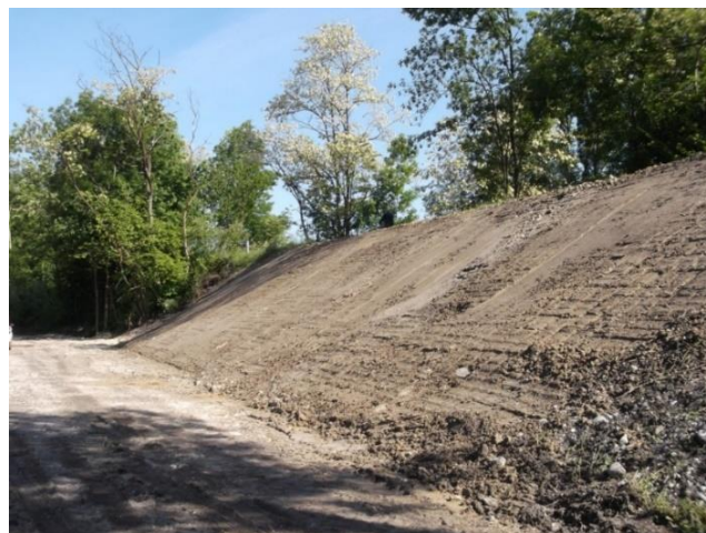
Figure 9.9 : Remise en état du site. Chantier Digue Isère aval à Noyarey (38) (Crédit Photo : SYMBHI)
