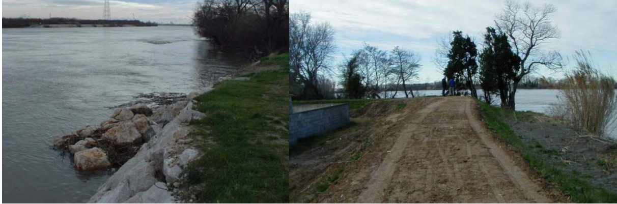
Figure D.8 : Pose d'enrochements côté amont (gauche) ou engraissement côté aval (droite) suite à affouillement (Crédit photo : SYMADREM)
