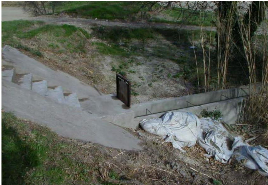
Figure D.13 : Intervention au droit d'un ouvrage traversant (Crédit photo : SYMADREM)
