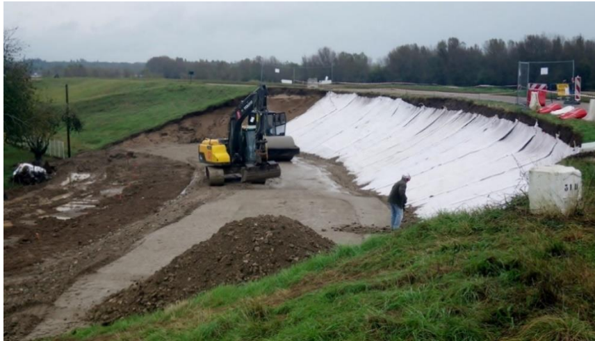
Figure 4.22 : Exemple du chantier de Bou la Binette, sur la Loire (2004) Le talus est recouvert par un géocomposite de drainage (on distingue les mini-drains en partie haute du talus). La recharge est réalisée en tout-venant classé B5 selon NF P11-300. On devine la fin du dispositif de drainage au pied de la pelle, sous la première couche mise en œuvre et compactée par un compacteur vibrant de type V5 (Crédit Photo DREAL Centre Val de Loire).
