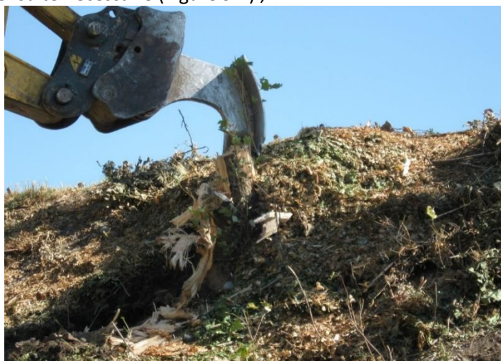
Figure 9.4 : Photographie d'un abattage définitif avec extraction partielle de la souche (Crédit photo : ADIDR – 2009 – Drac RG – Fontaine (38))
