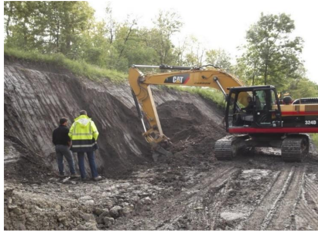
Figure 9.7 : Terrassement du remblai aval correspondant à la présence de terriers de blaireaux (terrassement jusqu'à ce qu'on ne trouve plus de cavités). Chantier Digue Isère aval à Noyarey (38) (Crédit Photo : SYMBHI)
