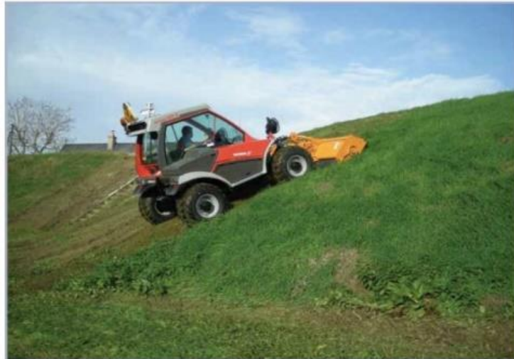
Figure 9.2 : Illustration de l'entretien de l'enherbement d'une digue (Crédit photo : Jean Maurin [9-6])
