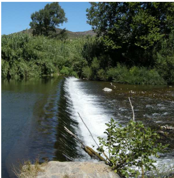
FIGURE 4.19 – Photo du seuil de dérivation du canal de la plaine (vue depuis le canal)
