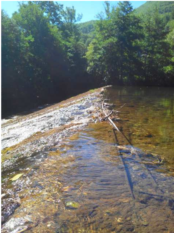
FIGURE 11.37 – Photo du seuil de dérivation du canal du Prat Pialoux (vue de la prise d'eau)
