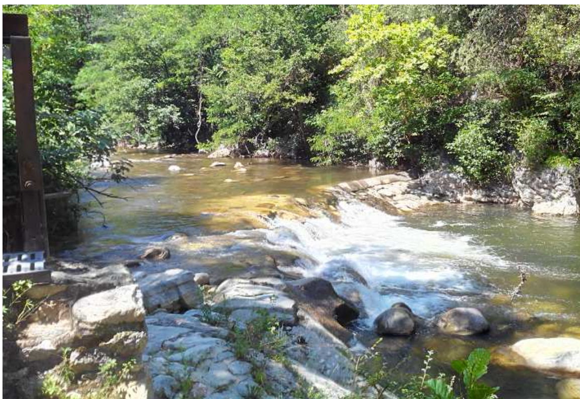
FIGURE 11.104 – Photo du seuil de dérivation du canal de branche ancienne (vue depuis la rive droite)
