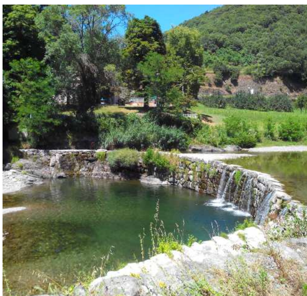
FIGURE 11.28 – Photo du seuil de dérivation du canal du Prat (vue de la rive gauche)
