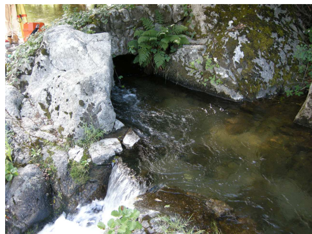
(b) Canal de Cambon (Gard)
