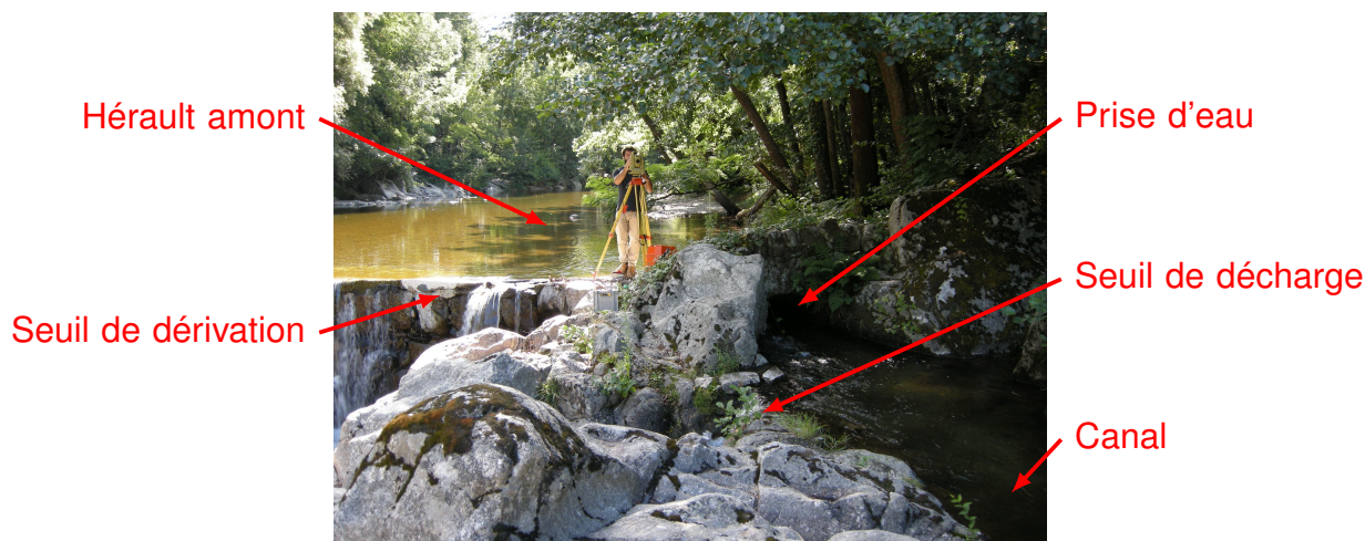
FIGURE 4.8 – Photo de la prise d'eau Canal de Cambon
