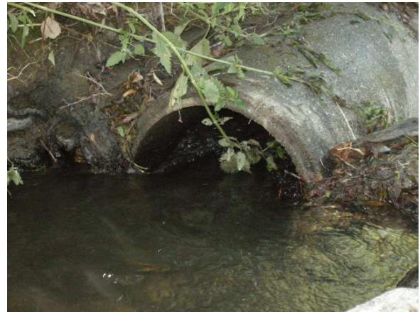
(b) Buse en entrée de canal
