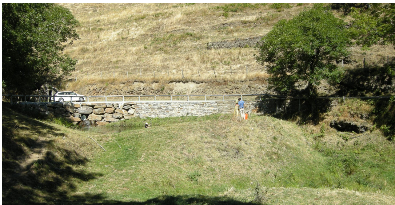
FIGURE 11.71 – Photo du bassin d'alimentation du canal de Pratlong
