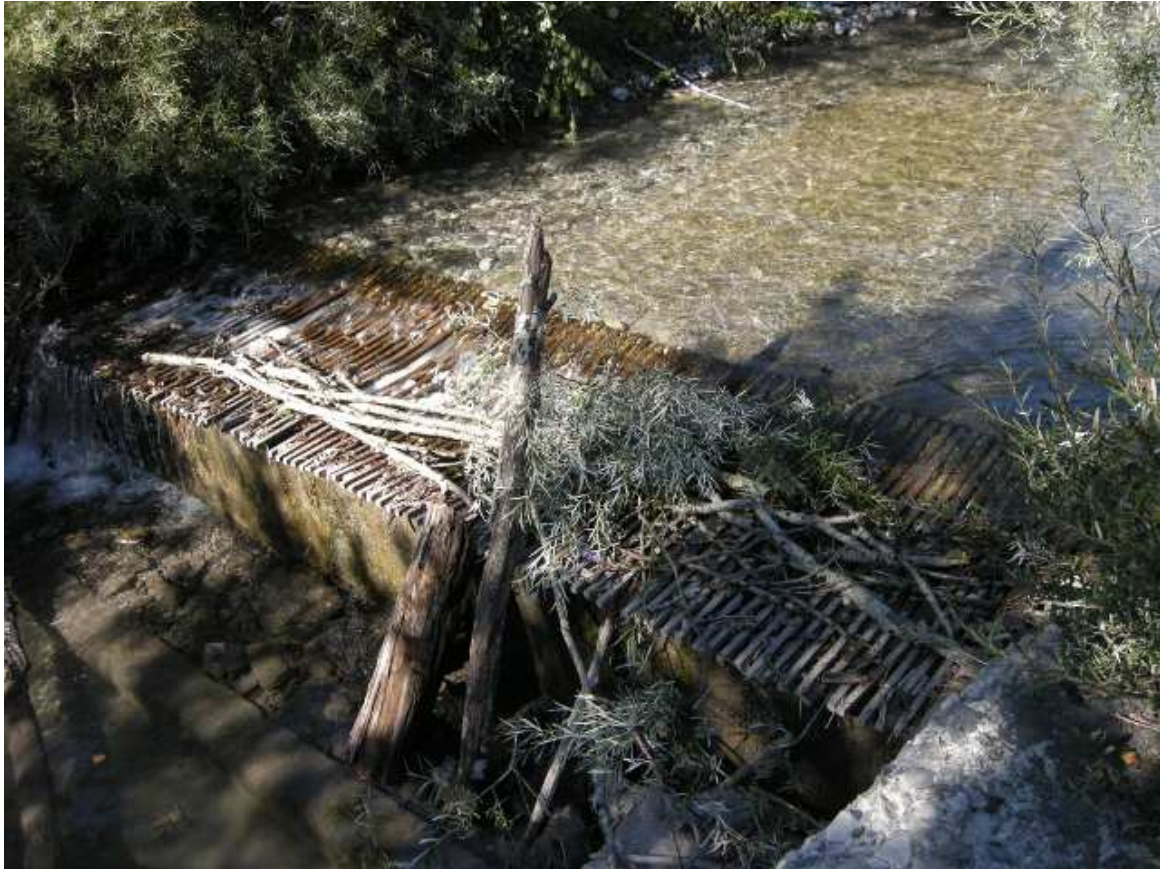
FIGURE 4.4 – Photo de la prise d'eau « par en-dessous » du canal du bourg sur la Bléone
