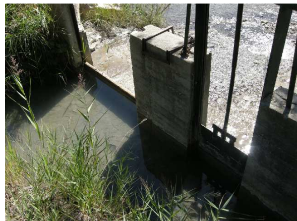
FIGURE 11.14 – Photo de la vanne de controle de débit dans le canal ainsi que de la vanne de controle du débit réservé (vue de l'amont)
