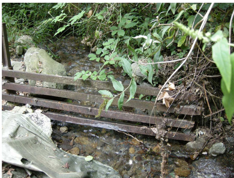
FIGURE 11.117 – Photo du canal de l'Évol et de la prise d'eau du canal (vue amont)
