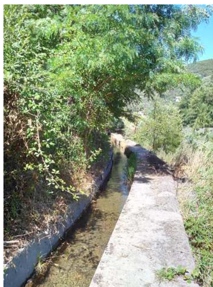
FIGURE 11.29 – Photo du canal du Prat (vue aval)
