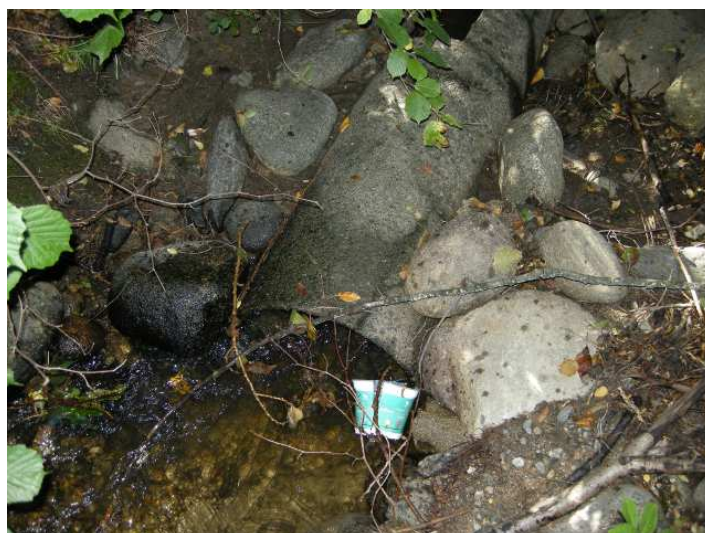
(b) Passage en souterrain du canal
