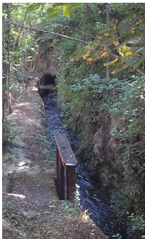
FIGURE 11.105 – Photo du canal de branche ancienne (vue amont)
