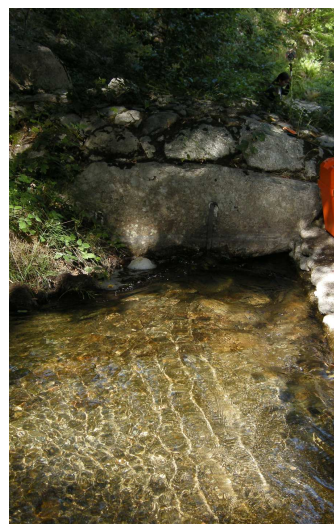
FIGURE 11.49 – Photo de la prise d'eau du canal de cambon
