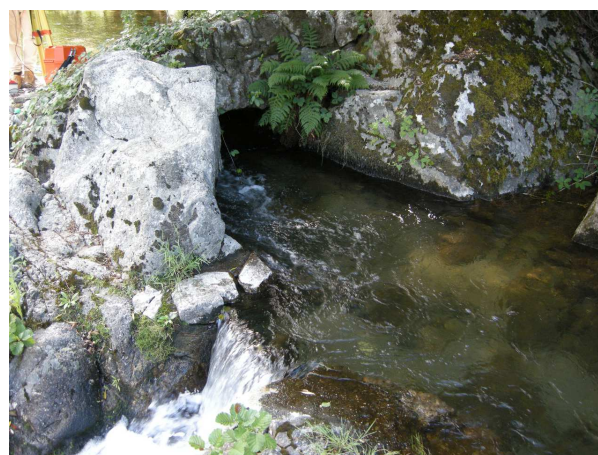
(b) Canal de Cambon (Gard)
