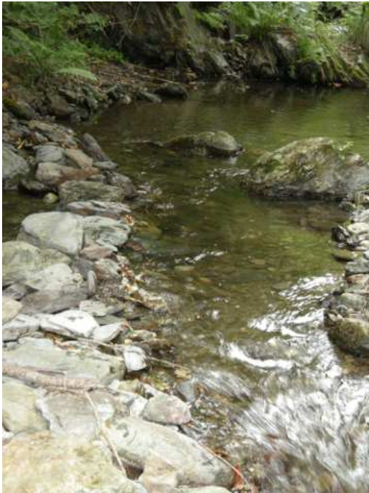
FIGURE 11.138 – Photo du seuil de dérivation du canal de l'Évol (vue de la prise d'eau)
