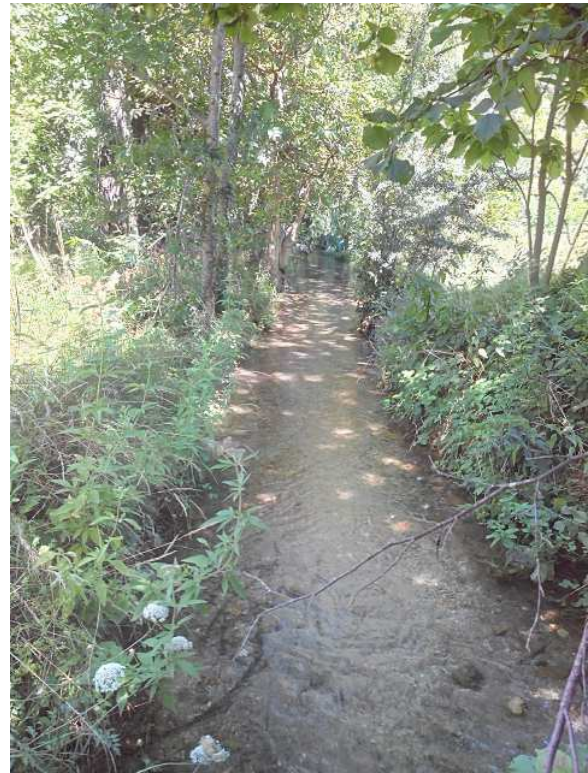
FIGURE 11.38 – Photo du canal du Prat Pialoux (vue de la prise d'eau)
