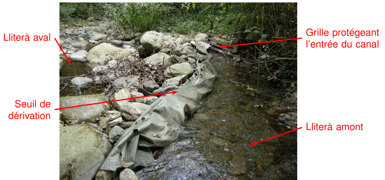
FIGURE 4.18 – Photo de la prise d'eau du canal de la Lliterà
