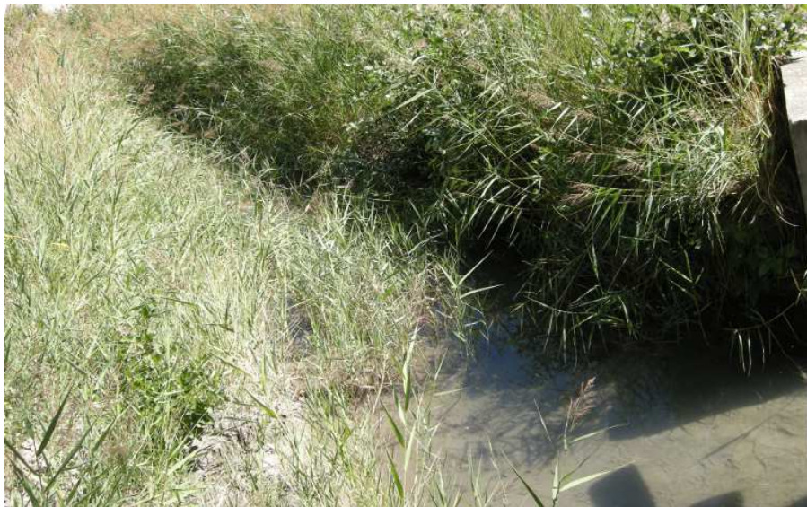
FIGURE 11.15 – Photo du canal d'amené (vue aval)
