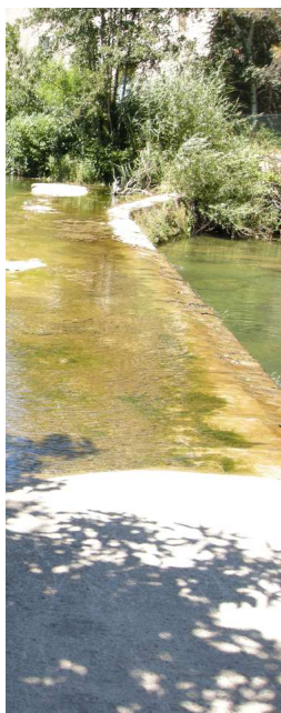
FIGURE 11.57 – Photo du seuil de dérivation du canal de saint Hippolyte (vue depuis la prise d'eau)
