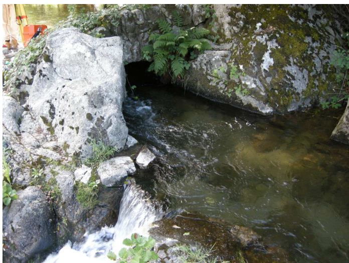
FIGURE 11.48 – Photo de la vanne de décharge du canal et de l'arrière de la prise d'eau du canal de cambon
