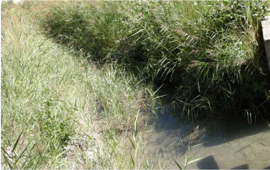
FIGURE 11.15 – Photo du canal d'amené (vue aval)
