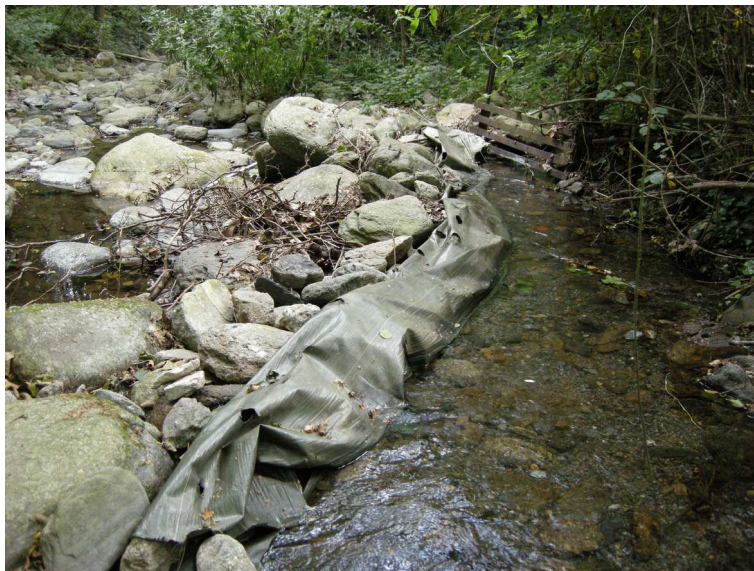
FIGURE 5.4 – Photo d'un seuil partiellement étanche (Canal de la Lliterà)
