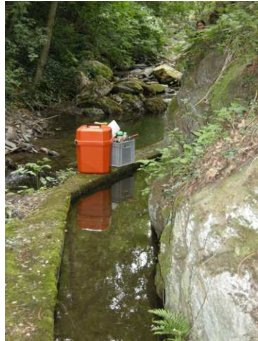
FIGURE 11.139 – Photo du canal d'Évol (vue depuis le dispositif de régulation du débit prélevé)
