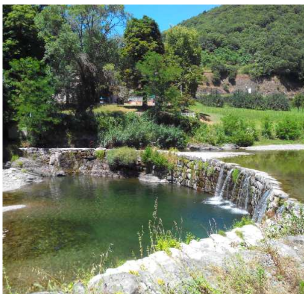
FIGURE 11.28 – Photo du seuil de dérivation du canal du Prat (vue de la rive gauche)
