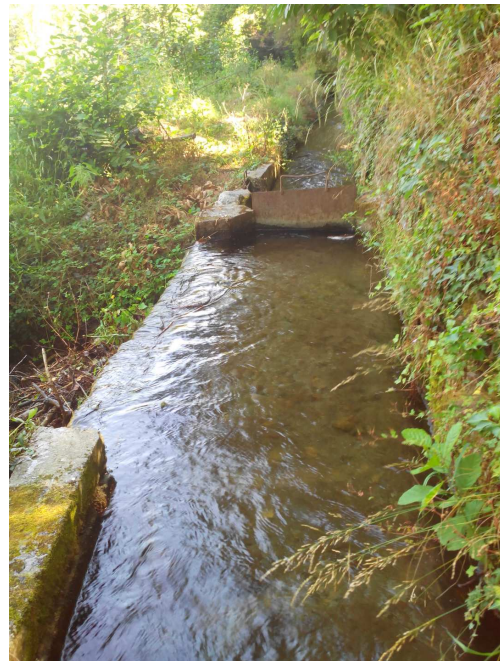
FIGURE 11.112 – Photo du seuil de décharge et de la vanne de régulation du débit prélevé par le canal situés plus de 250 m en aval de la prise d'eau (vue amont)
