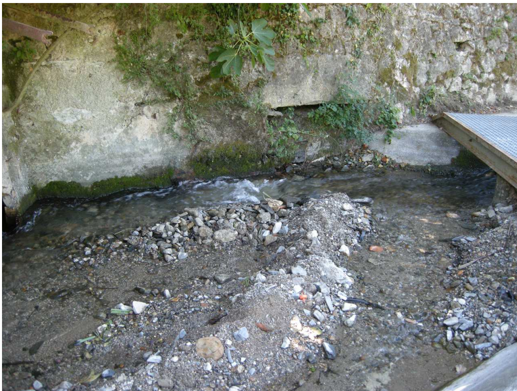
FIGURE 11.59 – Photo du canal de saint hippolyte
