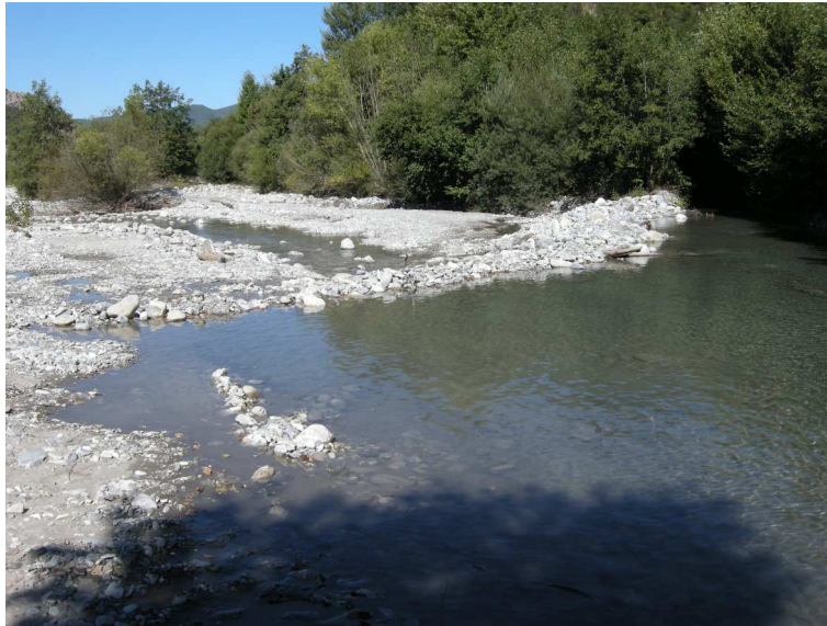
FIGURE 5.3 – Photo d'un seuil non étanche (Canal de Chaudol)
