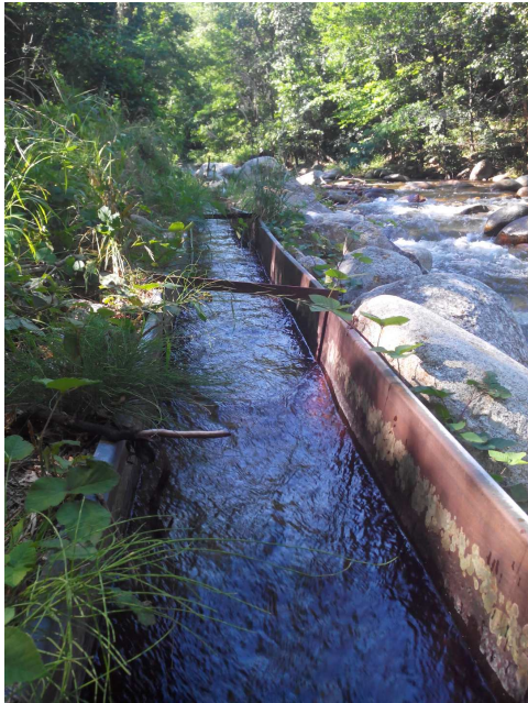
FIGURE 11.109 – Photo du canal du bac de joncet (vue aval)
