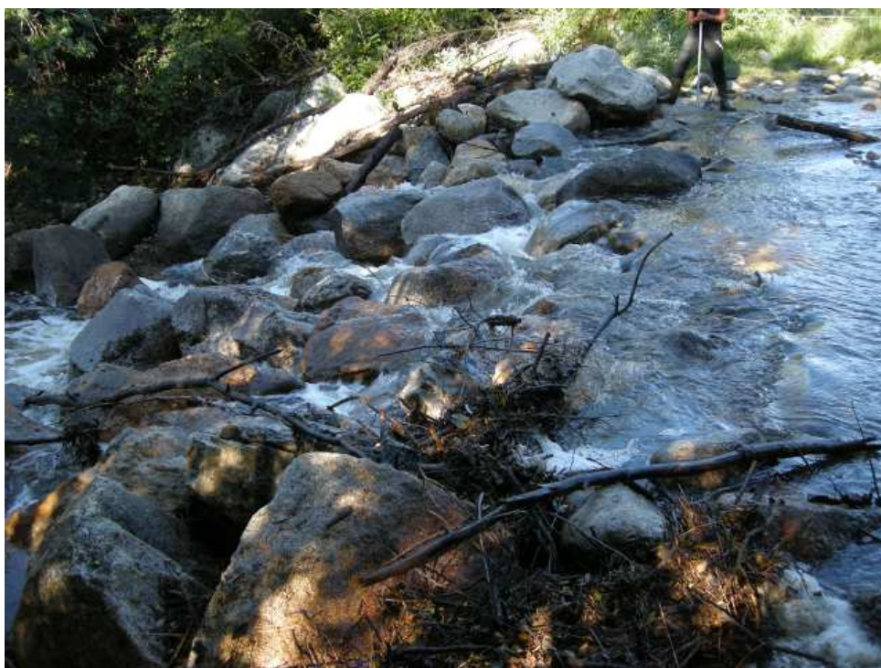
FIGURE 11.121 – Photo du seuil de dérivation du canal du Mas Blanc (vue de la prise d'eau)
