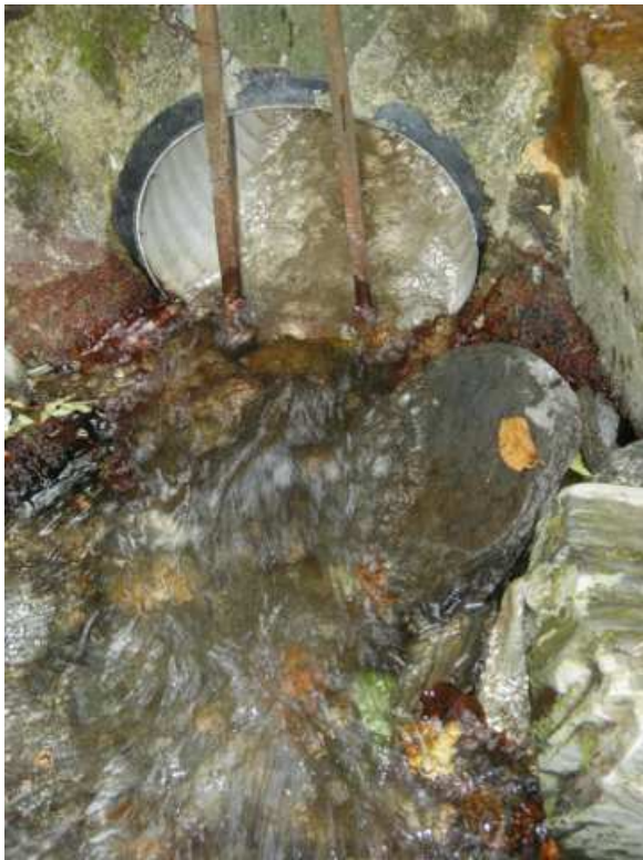
(a) Prise d'eau à l'entrée du canal
