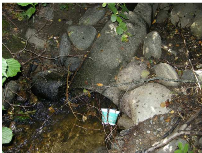
(b) Passage en souterrain du canal
