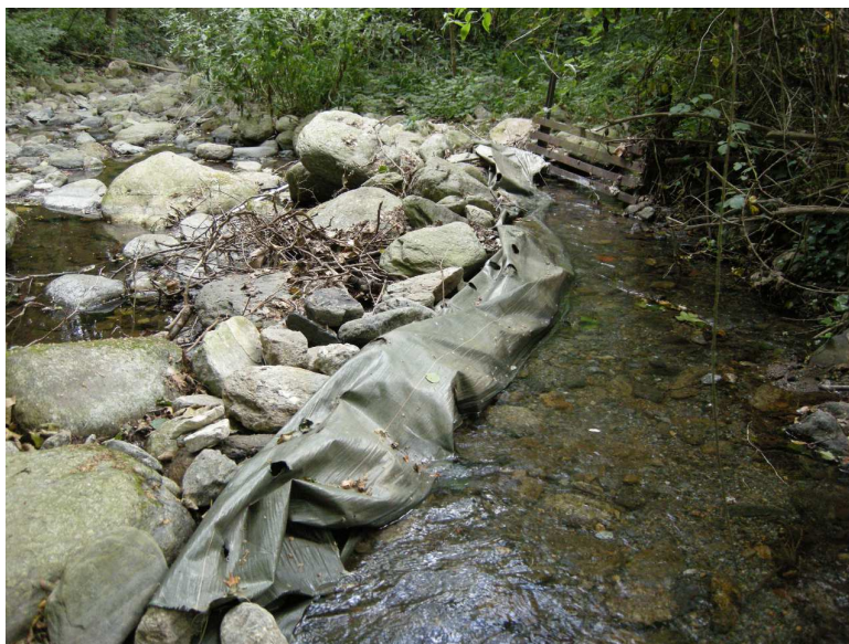
FIGURE 11.116 – Photo du seuil de dérivation du canal de la Iliteria (vue amont)
