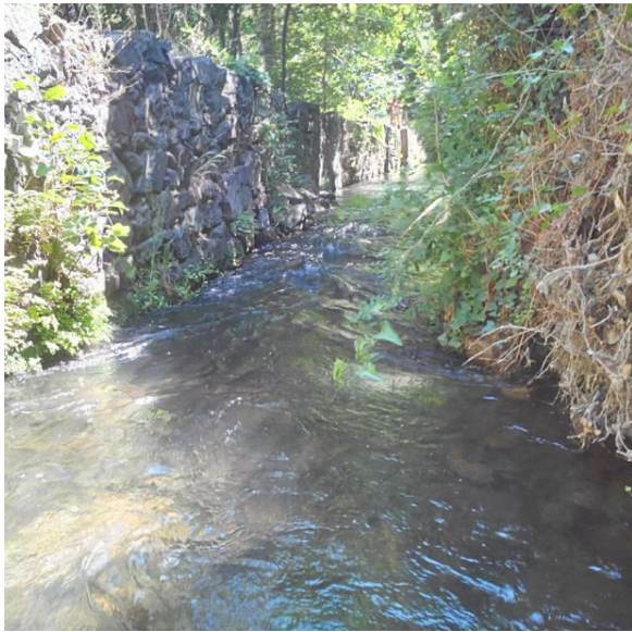
FIGURE 11.94 – Photo du canal de la plaine (vue de la prise d'eau)
