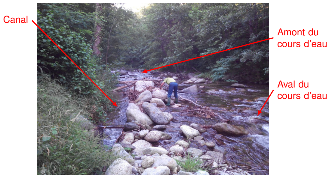
FIGURE 5.1 – Photo d'une prise d'eau sans seuil (Canal de Joncet)
