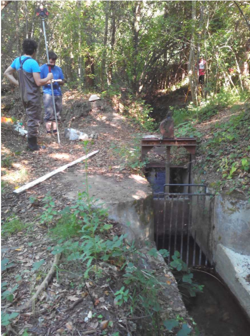
(a) Canal de Caudiès (P.-O.)
