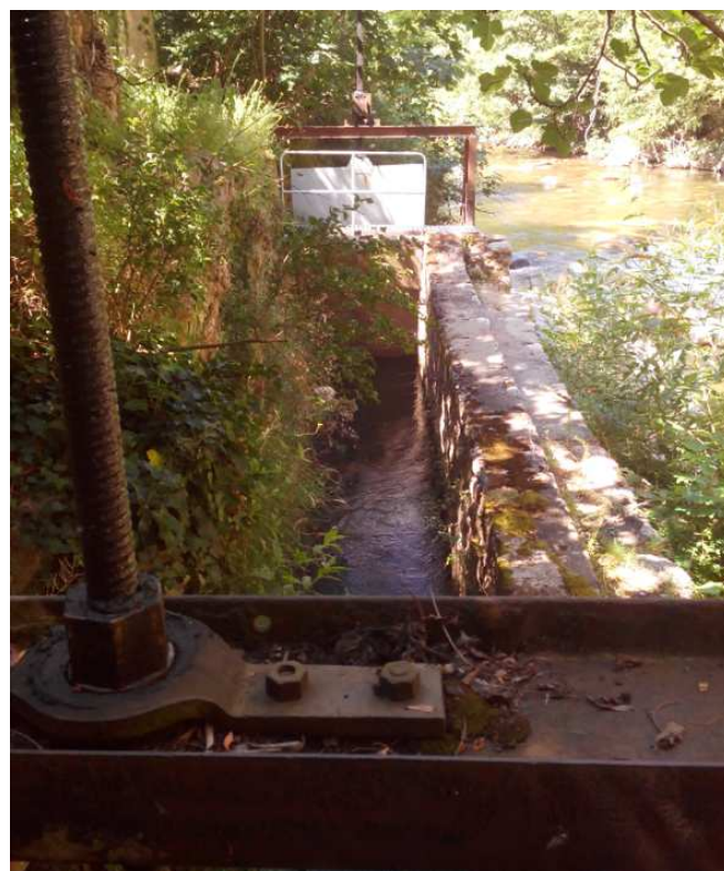
FIGURE 11.106 – Photo de la prise d'eau du canal de branche ancienne (vue aval)
