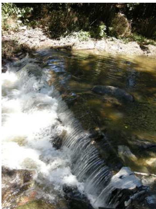
FIGURE 11.127 – Photo du seuil du canal de la prades (vue aval)
