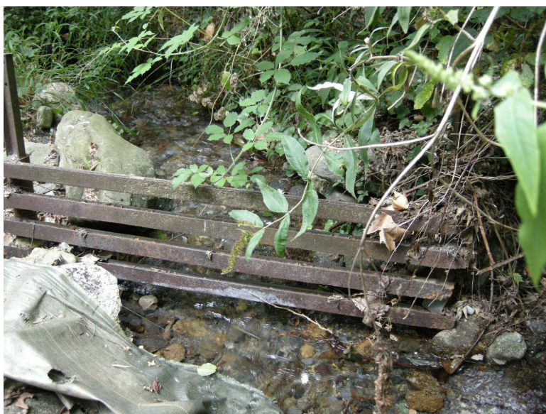
FIGURE 11.117 – Photo du canal de l'Évol et de la prise d'eau du canal (vue amont)
