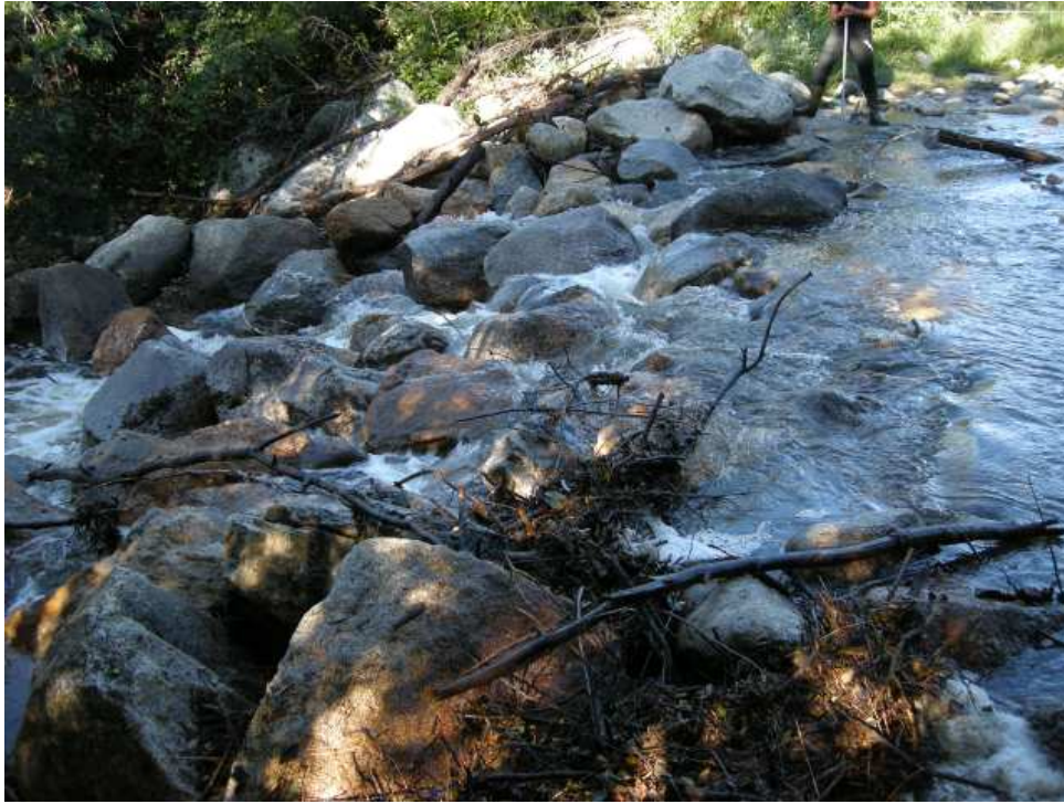
FIGURE 4.14 – Photo du seuil de dérivation du canal du Mas Blanc (vue de la prise d'eau)
