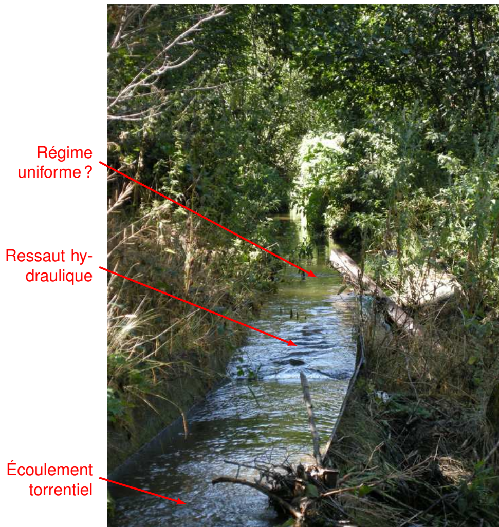
FIGURE 3.9 – Photo représentant différents régimes hydrauliques (Canal du Mas blanc, P.-O.)
