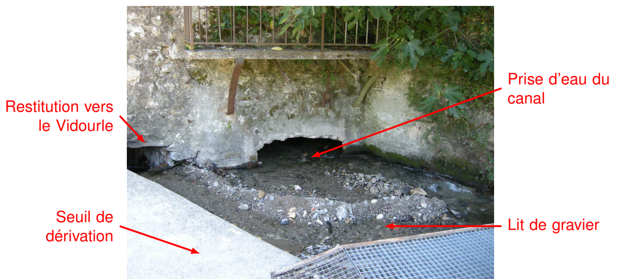
FIGURE 4.10 – Photo de la prise d'eau Canal de l'Agal
