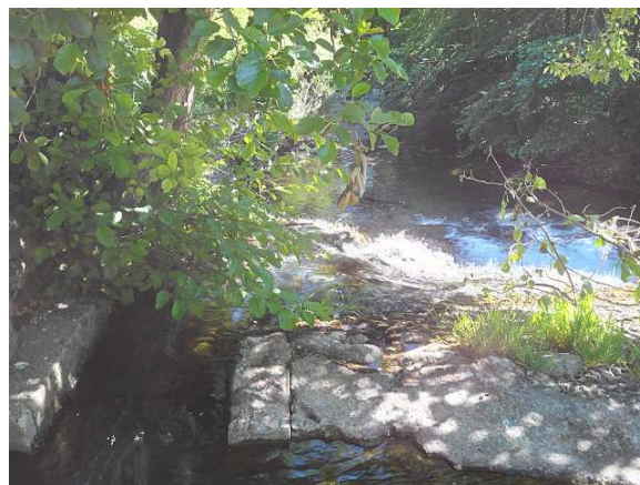
(b) Echancrure dans le seuil de dérivation
