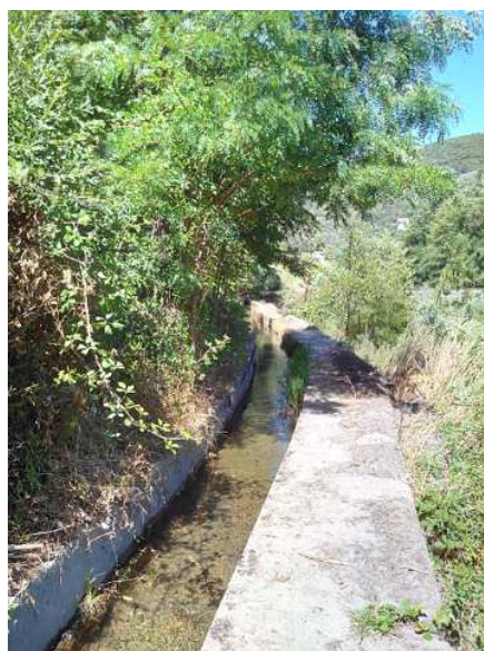
FIGURE 11.29 – Photo du canal du Prat (vue aval)
