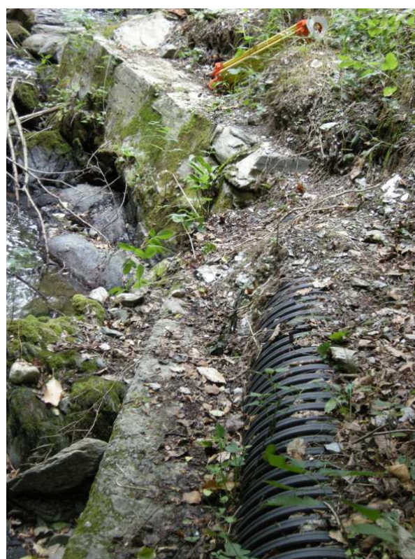
(b) Buse vue de l'aval
