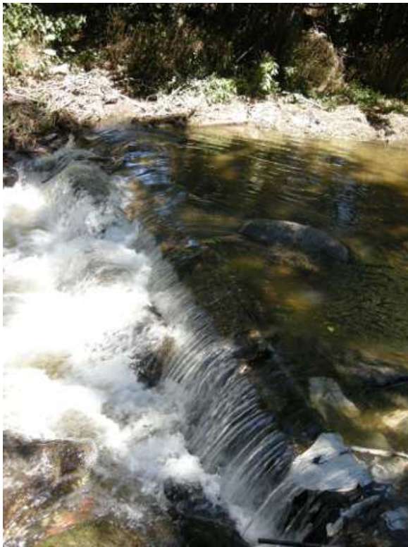
(a) Seuil de dérivation
