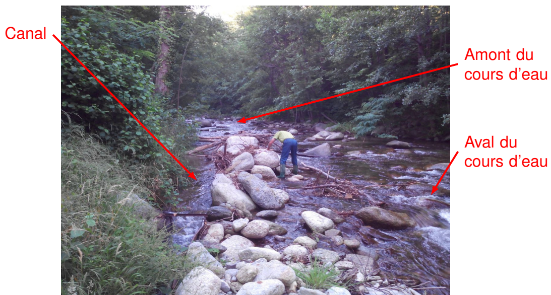
FIGURE 4.15 – Photo de la prise d'eau du canal du Bac de Joncet
