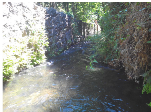
FIGURE 11.97 – Photo du canal de la plaine à l'aval de l'échelle limnimétrique
