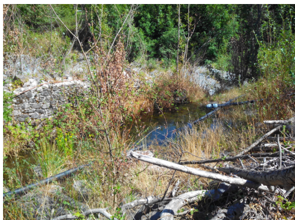
(a) prelevement par pompage
