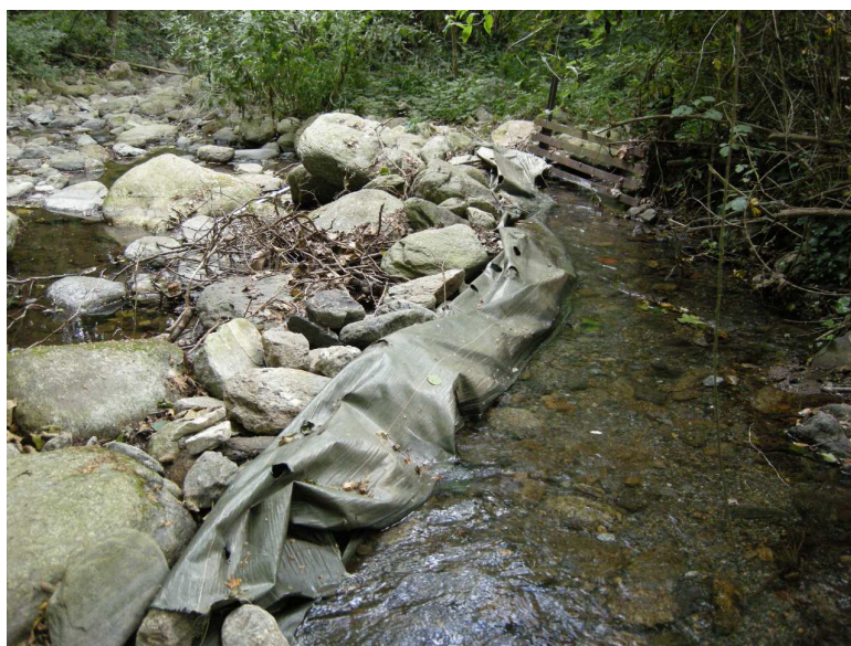
FIGURE 11.116 – Photo du seuil de dérivation du canal de la Iliteria (vue amont)
