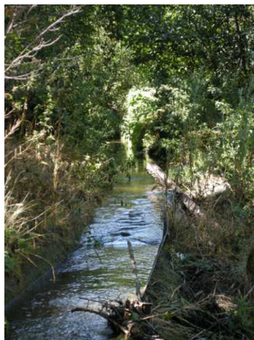
FIGURE 11.128 – Photo du canal de la prades (vue aval)
