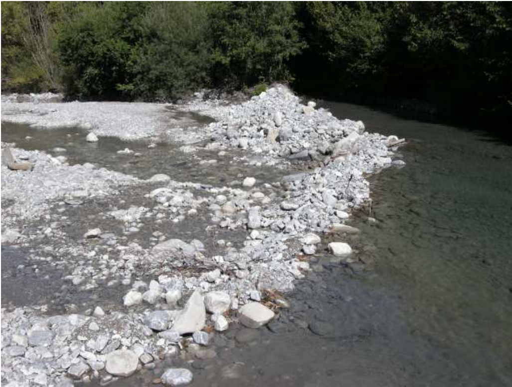
FIGURE 11.2 – Photo du seuil de dérivation du canal de Chaudol (vue de la prise d'eau)
