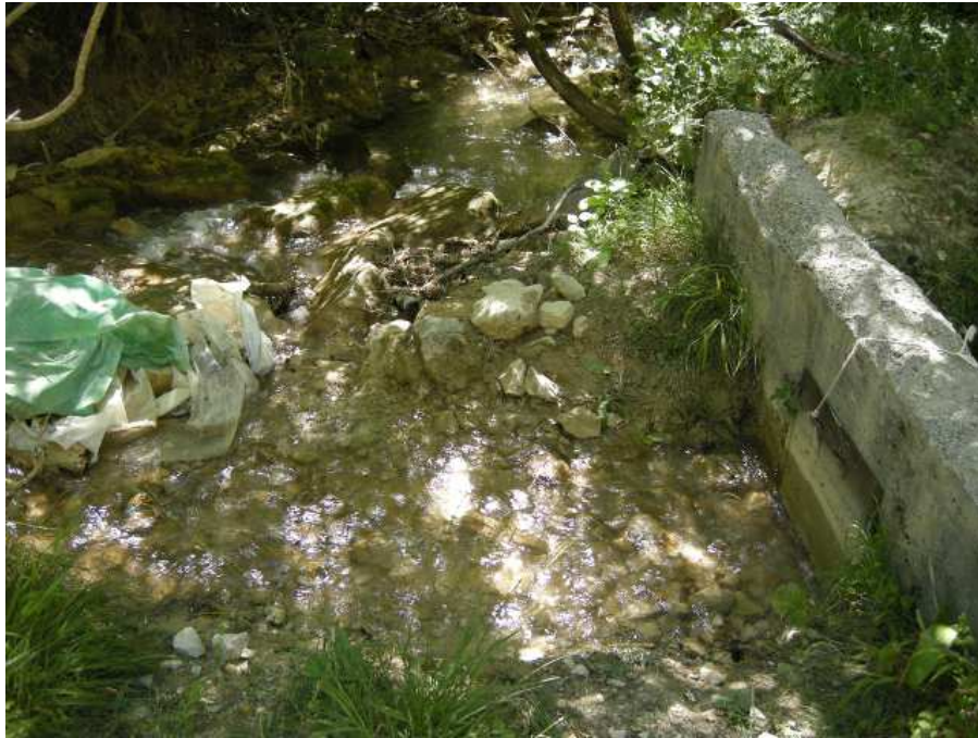
FIGURE 11.21 – Photo du seuil de dérivation du canal de Gion (vue de la rive droite)
