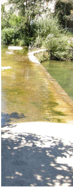
FIGURE 11.57 – Photo du seuil de dérivation du canal de saint Hippolyte (vue depuis la prise d'eau)
