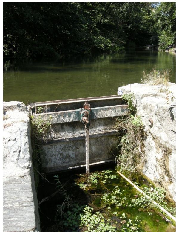
FIGURE 11.93 – Photo de la vanne de restitution du débit réservé du canal de la plaine
