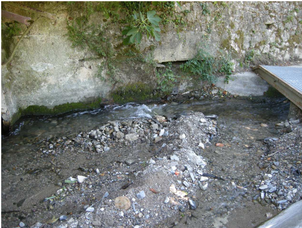
FIGURE 11.59 – Photo du canal de saint hippolyte
