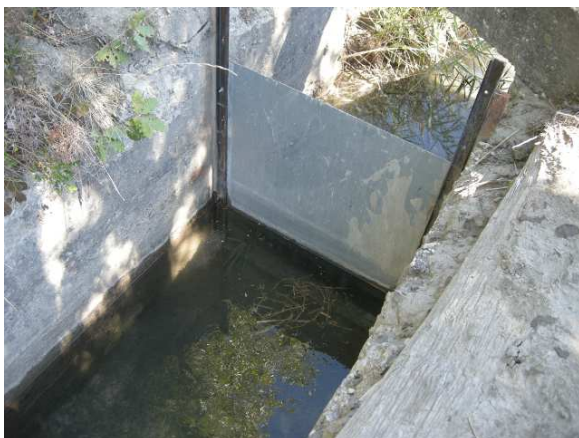
(a) Vanne prise d'eau (vue aval)
