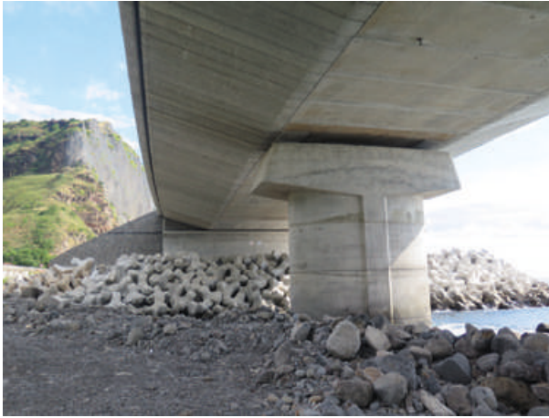
Fig. 4 Débouché de la ravine de la Grande Chaloupe
