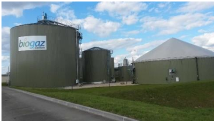
crédit photo : biogaz Gaillon
