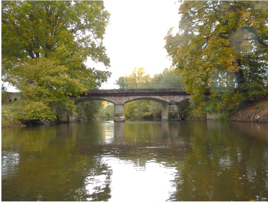
Figure 3. Photographie de la station S5 au pont de Signy
