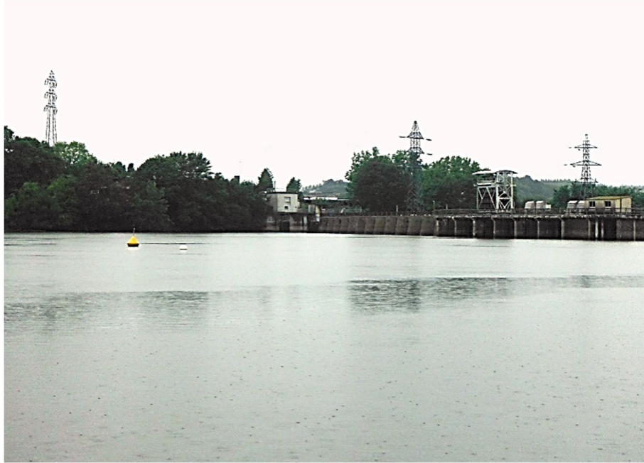
Figure 5. Photographie de la station S3 sur la retenue du barrage de Vezins
