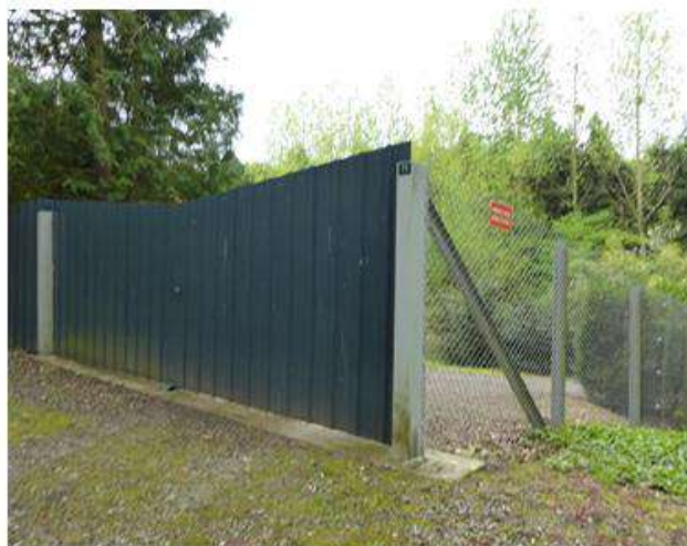
Figure 84 – Accès à une cabane (clôture présente jusqu'à la berge), 2014 (Cliché : MV)
