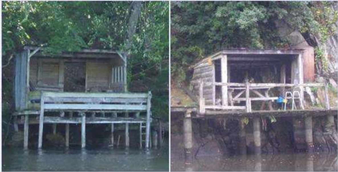
Figure 50 – Constructions du type « abri sommaire », 2014 (Cliché : MV)
