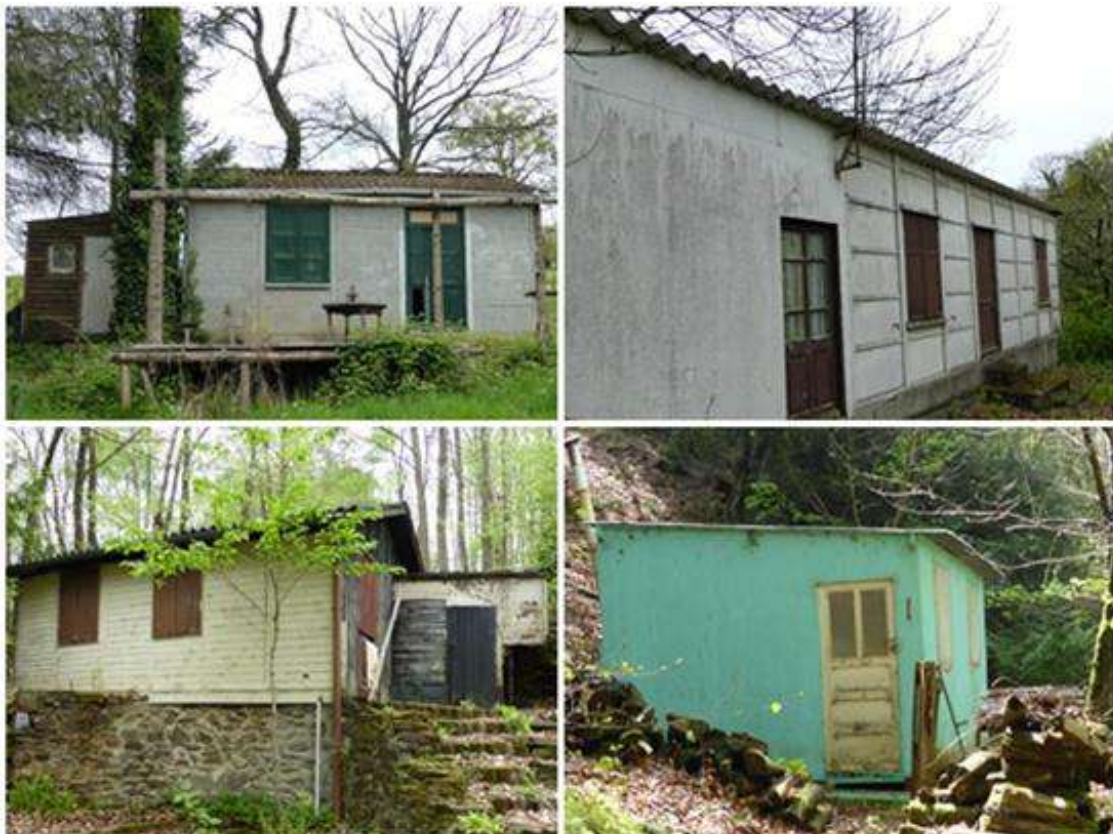
Figure 51 – Constructions du type « cabane », 2014 (Cliché : MV)
