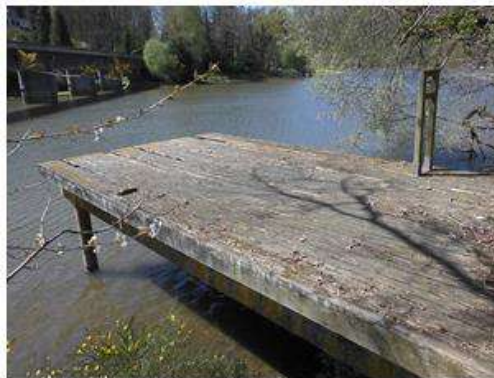
Figure 65 : Ponton en bois (pont de la République, 2014 (Cliché : MV)
