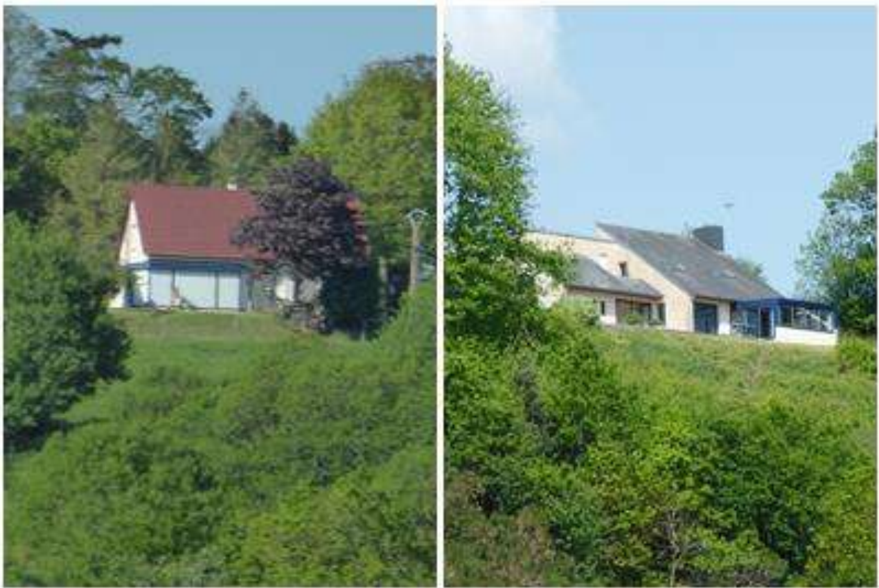
Figure 70 : Bâtiment avec vue sur le lac de Vezins (Rive droite - photos prises en barque depuis le lac), 2014 (Cliché : MV)
