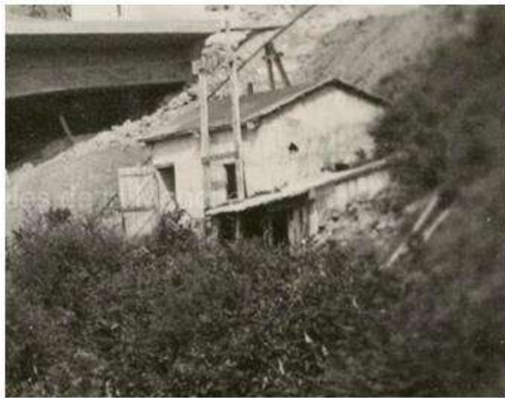
Figure 75: Cabane présente dès la construction du pont des Biards (28 juin 1931) Source : Archives Départementales de la Manche (49 Fi 121)
