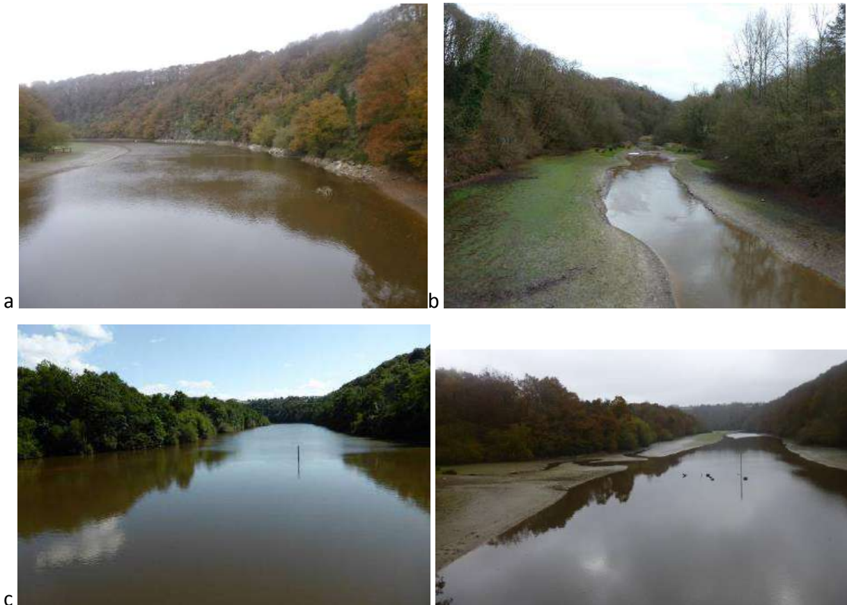
Figure 96 – a/Pont de la République, novembre 2014 (cliché 115C) ; b/Pont sur le Lair, février 2014 (cliché 183A) ; c/ Pont de la République, août et novembre 2014 (cliché 115B) (Clichés : AJ et MAG)
