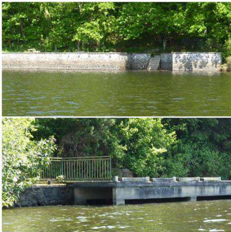
Figure 68 : Berges aménagées avec une plateforme en dur, 2014 (Clichés : MV)
