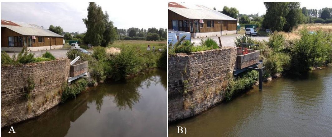
Figure 3. Site d'installation du DIDSON. A) Après la pose d'un IPN sous l'avancée bétonnée (juin 2013); B) Après la mise en place de l'IPN vertical et de la potence (juillet 2013)
