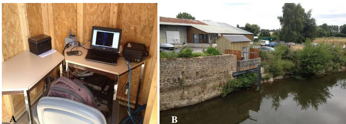
Figure 3. Site d'installation fonctionnel (26 juillet 2013). A : intérieur de l'abri ; B : vue à partir du Vieux Pont de Ducey
