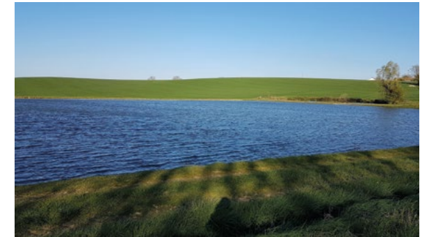
Retenue collinaire située à Peyrière (47). Ce type de plan d'eau artificiel à l'origine, sert principalement à l'irrigation et d'appui à l'agriculture. Certaines retenues possèdent une activité récréative de type piscicole. Globalement, elles jouent également un rôle écologique en fournissant de l'eau à la faune, dans des secteurs où les pluies sont rares en été.
