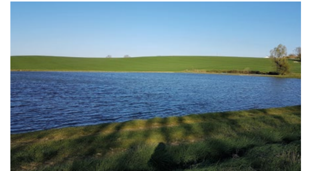
Retenue collinaire située à Peyrière (47). Ce type de plan d'eau artificiel à l'origine, sert principalement à l'irrigation et d'appui à l'agriculture. Certaines retenues possèdent une activité récréative de type piscicole. Globalement, elles jouent également un rôle écologique en fournissant de l'eau à la faune, dans des secteurs où les pluies sont rares en été.
