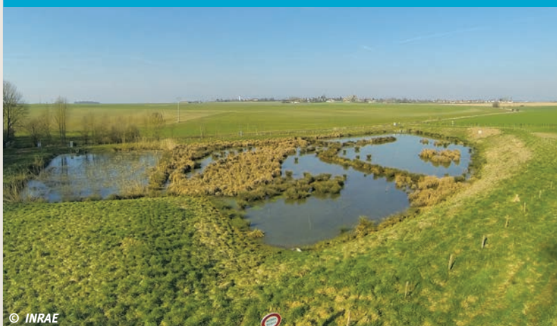
3 Zone tampon humide artificielle (ZTHA) en contexte de grandes cultures, Seine-et-Marne.
