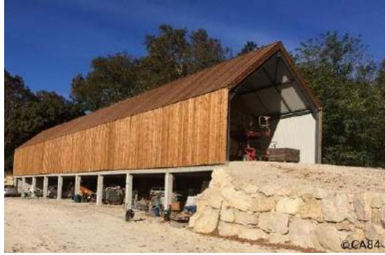
FIGURE 9 – Photo de la surélévation d'un bâtiment agricole
