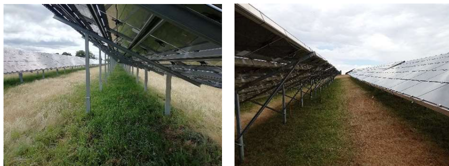
Illustration 2 : Photographique sur le site de Braize (gauche) et le site de Marmanhac (droite) durant la période de sécheresse montrant la différence prononcée de l'état de la végétation entre l'inter-rangée et sous les panneaux.
