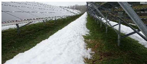
Illustration 3 : Photographie sur le site de Marmanhac montrant la protection des panneaux face aux chutes de neige.
