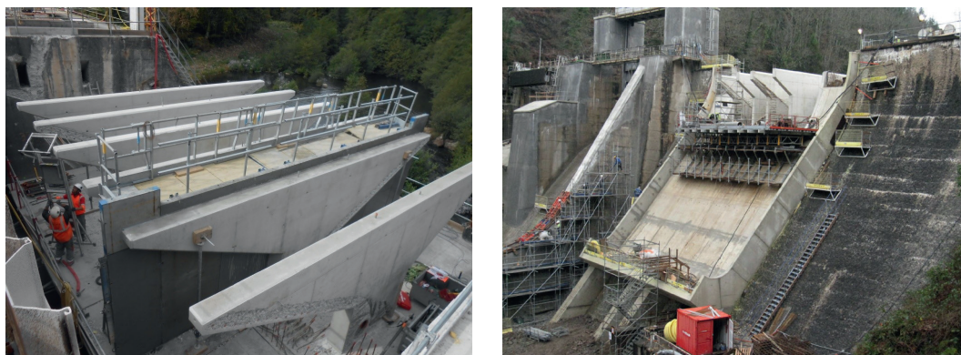
Figure 3.8 – a) Barrage de Record sur l'Agout (2015) – Remplacement de quatre vannes segments par quatre PKW à l'abri d'un batardeau provisoire permettant de maintenir l'ouvrage en service, b) PKW installé sur le barrage de l'Étroit (2009) /
