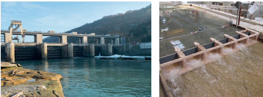
Figure 8.9 – Barrage de Beaumont-Montoux / © EDF-Philippe GROLLIER/PWP et vue du modèle physique / © Artelia
