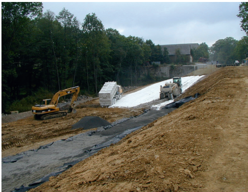
Figure 7.12 – Digue de Hvezda (République Tchèque, photo 2003) – À la suite d'inondations, traitement de sédiments humides à la chaux pour la reconstruction de la digue / @ Lhoist
