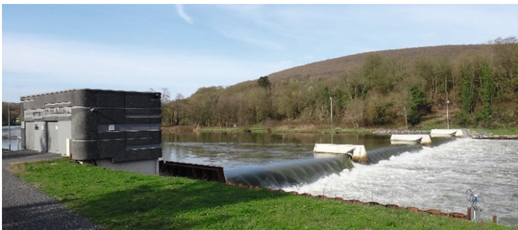
Figure 8.14 – Barrage de Fépin mis en service le 23 octobre 2018 / © BRLi
