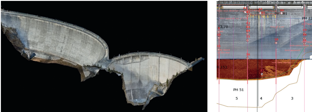
Figures 11.13 et 11.14 – Exploitation de prises de vues par drone : à gauche modèle 3D et à droite tracé des résultats d'inspection sur orthophoto 2D / © EDF
