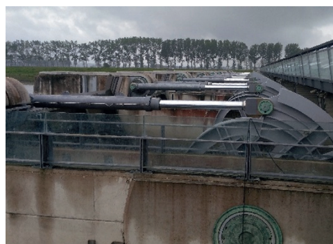
Figure 8.20 – Organes de manœuvre, bras et vérins des vannes, à marée haute / © BRli
