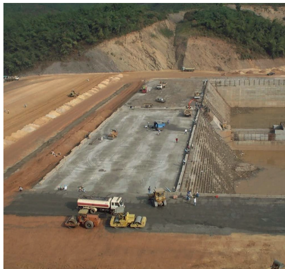
Figure 7.2 – Barrage de Mae Suai (Thaïlande) en construction /
