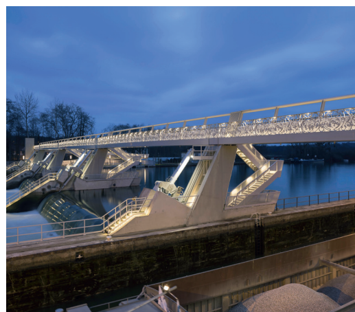
Figure 8.12 – Barrage mis en service le 23 octobre 2019 / © Artelia – Hervé Abbadie
