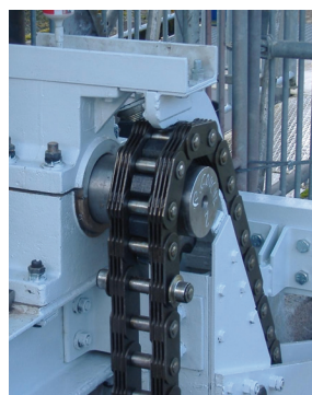
Figure 12.5 – Examen de l'état de la chaîne Galle de manœuvre d'une vanne d'évacuateur de crues / © EDF
