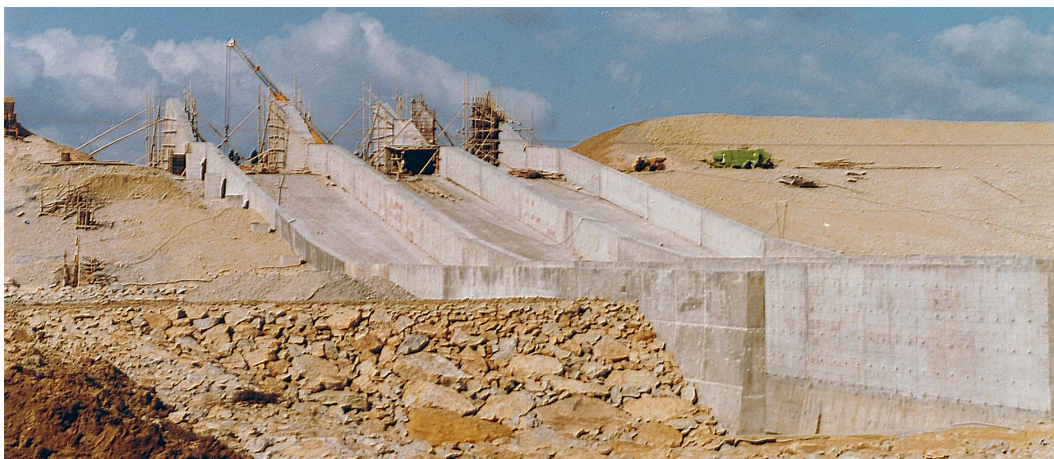
Figure 7.6 – Barrage du Lebna : parement aval avec son évacuateur / @ Coyne et Bellier
