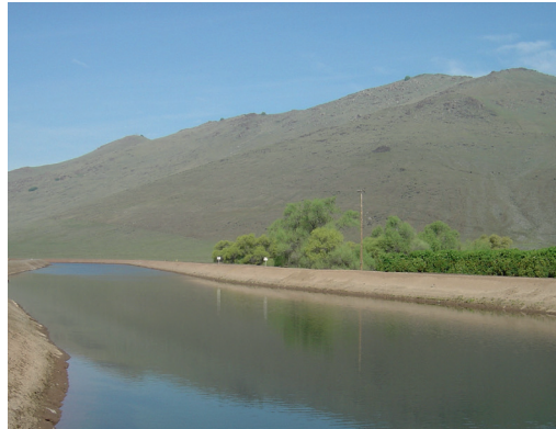
Figure 7.11 – Canal de Friant Kern (USA, photo 2012) – Tronçon de berge remis en état en 1973 par traitement à la chaux des sols gonflants, sans dalle de protection en béton / @ Lhoist
