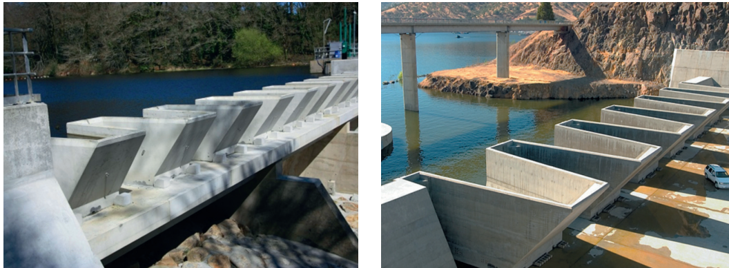
Figure 3.9 – Hausses fusibles béton sur le barrage de Tréauray (2014) et sur le barrage de Terminus aux USA (2004) / © Hydroplus
