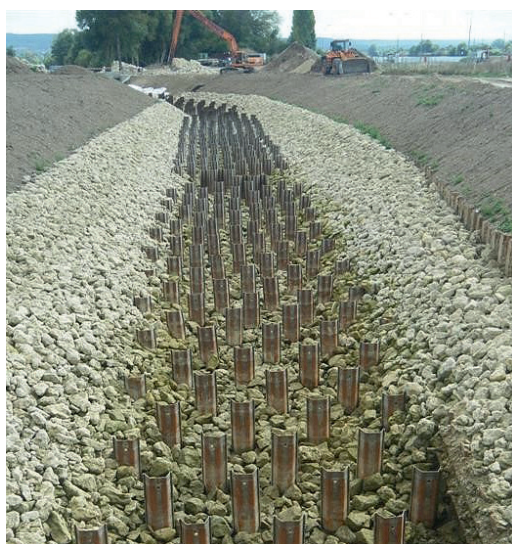
Figure 8.17 – Photos des macro-rugosités hors d'eau et en eau / © BRLi
