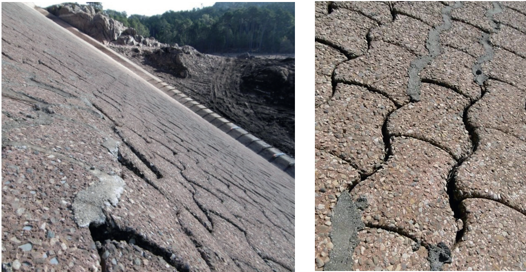
Figure 7.8 – Bombement (gauche) – Granulats apparents et lessivage du liant (droite) /
