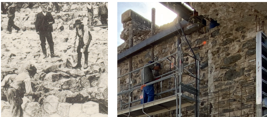
Figure 5.5 – Hétérogénéité de la granulométrie des blocs et du remplissage au mortier, barrages de Rochebut et de Chazilly / © ISL Olivier Lapeyre
