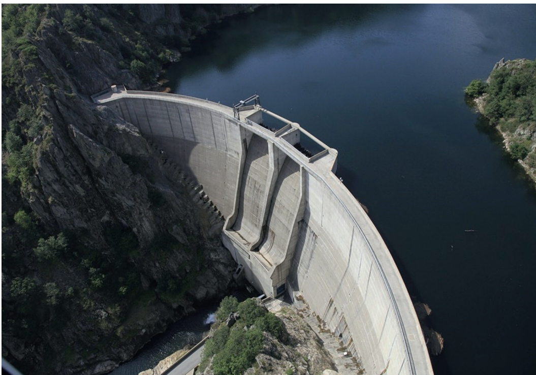
Figure 6.4 – Barrage de Puylaurent, dernière voûte construite en France en 1996 /
