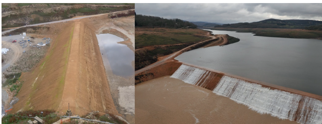
Figure 9.10 – Batardeau de Pannecièrre en construction et en surverse / © BETCGB/ISL
