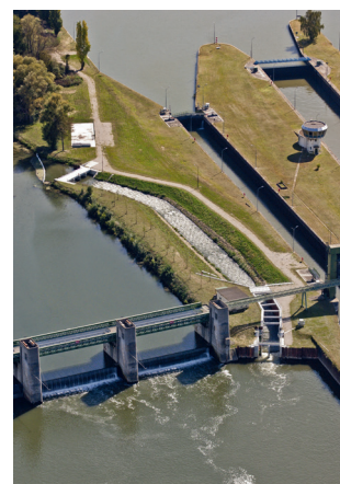
Figure 8.16 – Barrage, passe à poissons et écluses de Notre-Dame-de-la-Garenne / © VNF
