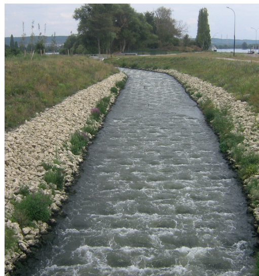
Figure 8.17 – Photos des macro-rugosités hors d'eau et en eau / © BRLi
