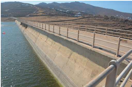
Marathia (Grèce) – 1993 : 1 er barrage remblai dur ; H = 31 m © M. Dunstan
