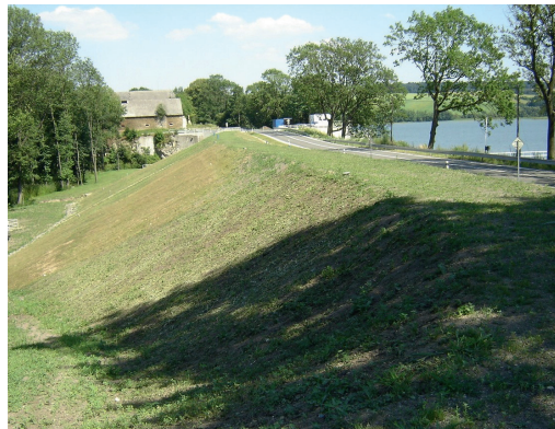
Figure 7.13 – Digue de Hvezda (République Tchèque, photo 2003) – Aspect général de la digue après reconstruction / @ Lhoist
