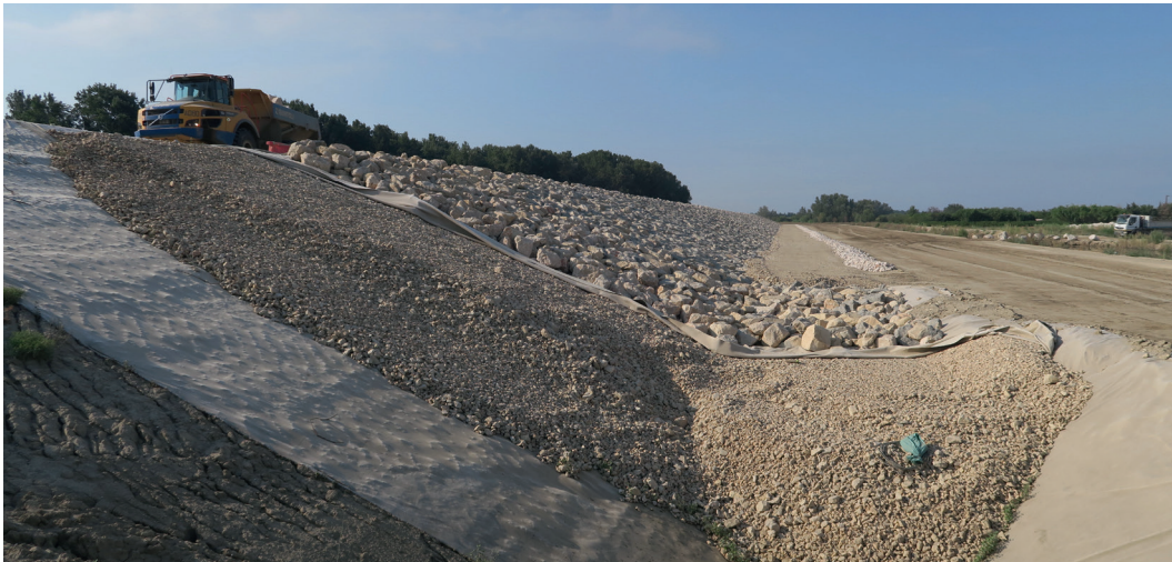
Figure 9.2 – Réalisation d'une digue résistante à la surverse avec tous les composants nécessaires à sa sûreté et sa durabilité (étanchéité, filtration, drainage, évacuation des crues) / © Symadrem
