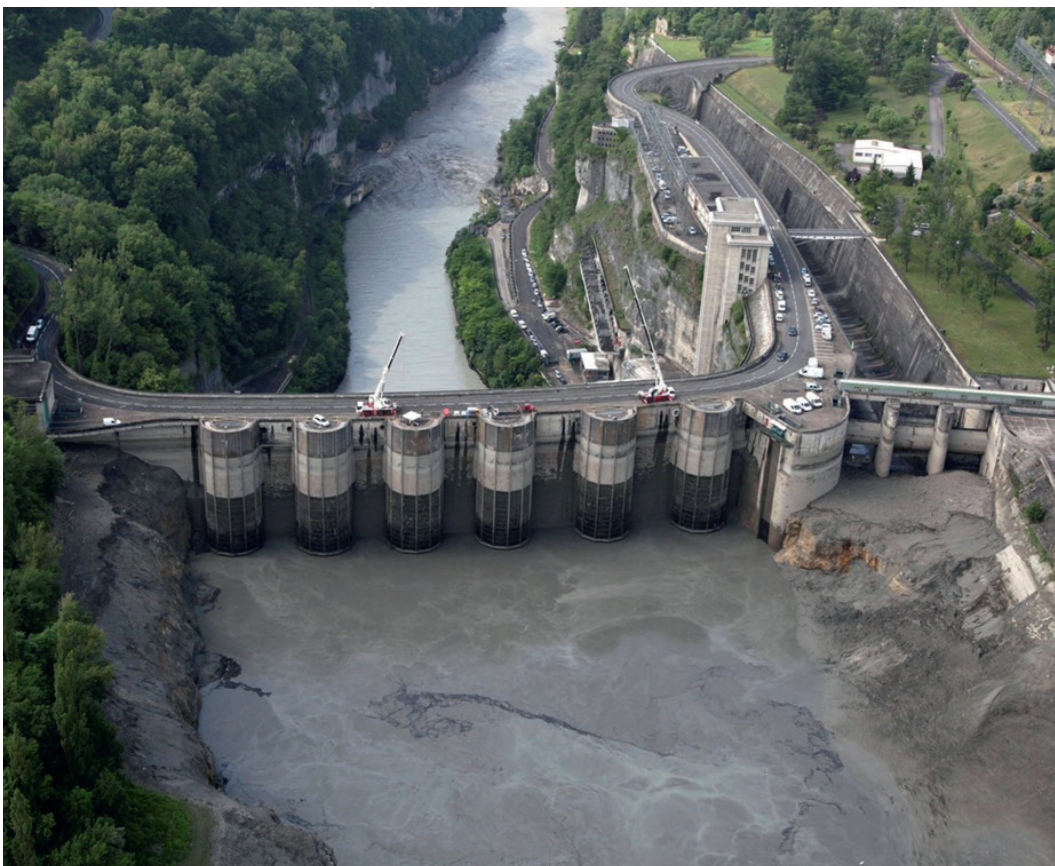
Figure 4.1 – Abaissement contrôlé de la retenue de Génissiat lors de l'opération des chasses suisses du Haut-Rhône en 2012 / © CNR – Camille Bezzina
