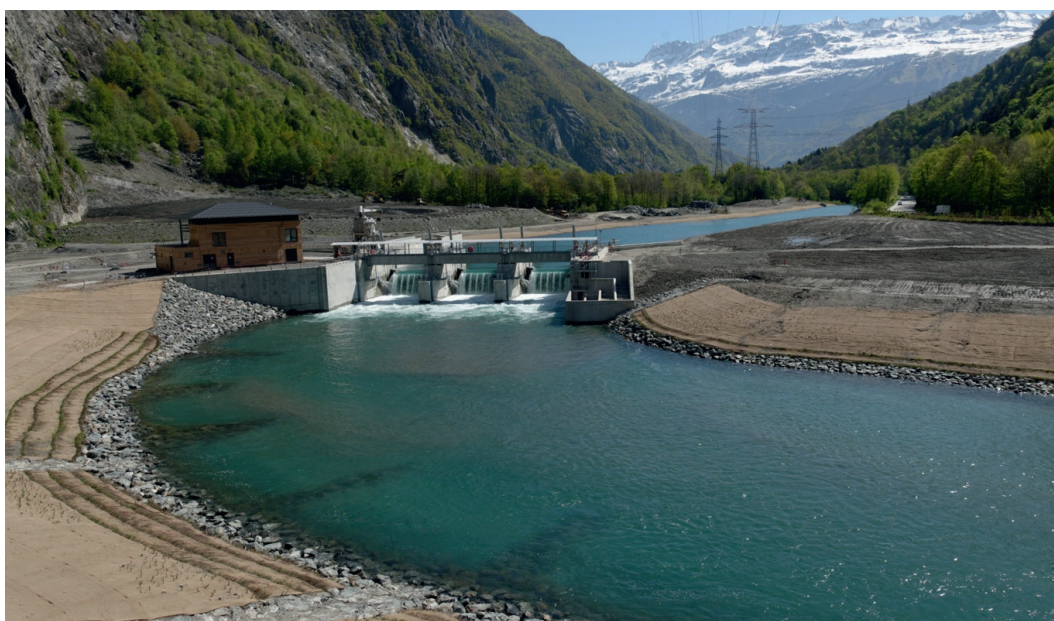
Figure 8.18 – Barrage-prise d'eau de Livet / © EDF-Christophe Huret
