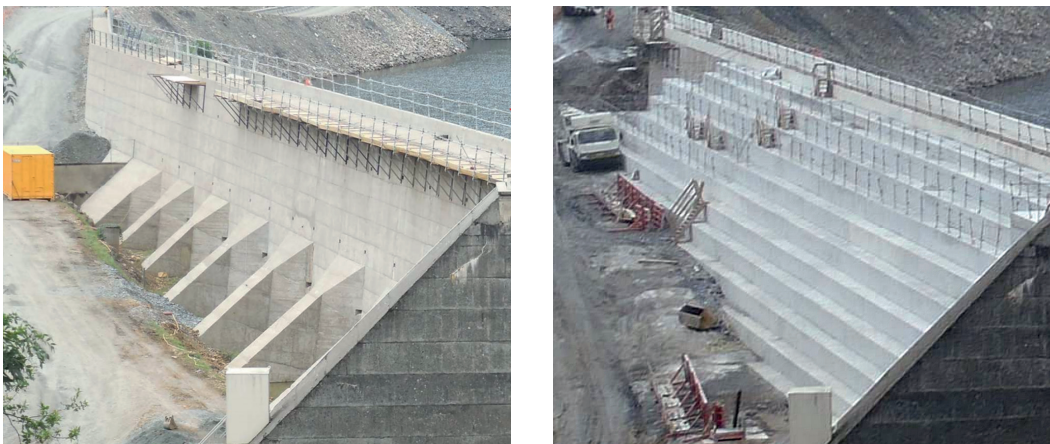
Figure 5.11 – Barrage de Rassisse, confortement par massif-poids (à gauche : avant ; à droite : après confortement) / © ISL – Anthony Dols
