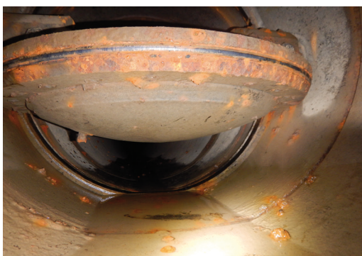
Figure 12.4 – Examen de l'état de la lentille d'une vanne papillon dans un conduit de vidange / © EDF
