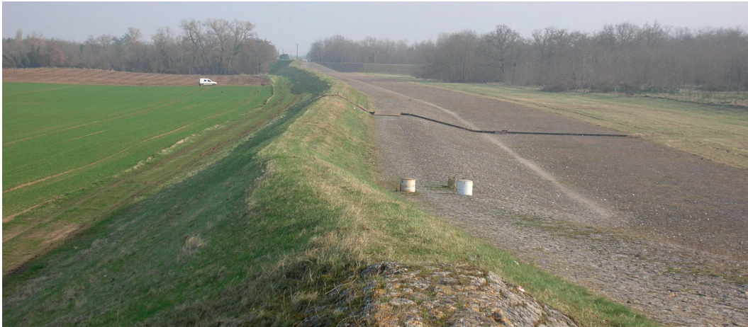
Figure 9.4 – Déversoir de Jargeau (Val d'Orléans 45) – De gauche à droite terrain non protégé, fusible, talus aval non érodable, zone de dissipation et val protégé /
