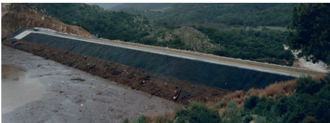
Figure 7.9 – Barrage de l'Ortolo : crue en construction. Parements amont (haut) et aval (bas) / @ A. Sanguinetti
