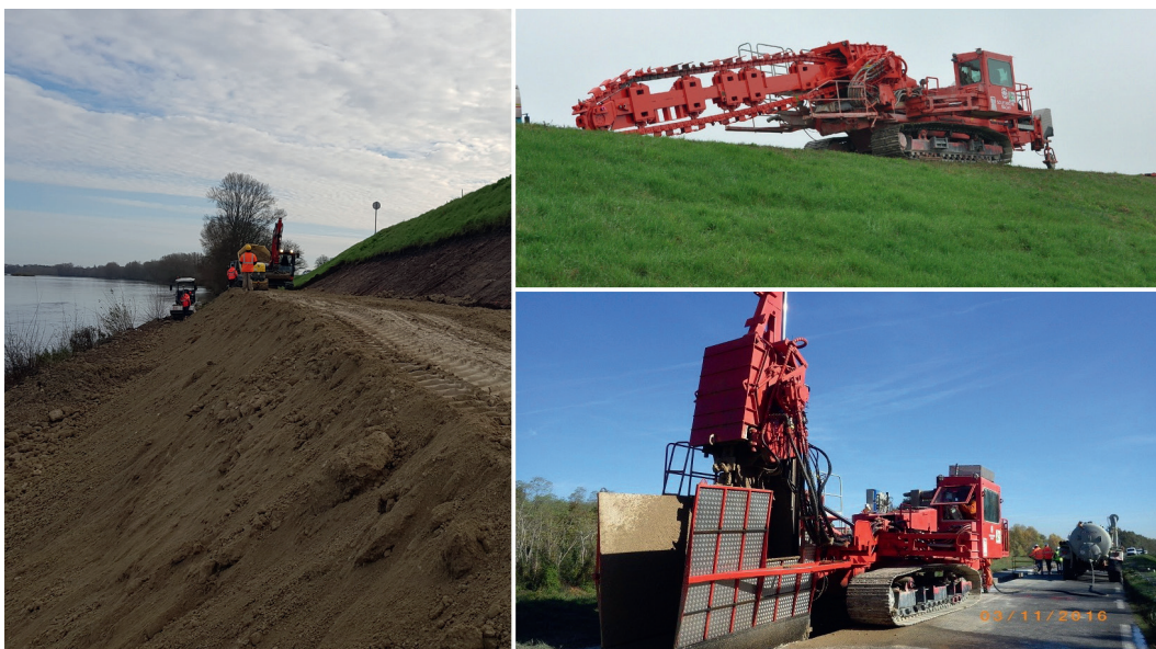
Figure 9.6 – Travaux de renforcement du talus côté Loire (à gauche) et écran étanche « deep soil mixing » dans la levée d’Orléans (à droite) / © DREAL Centre-Val de Loire
