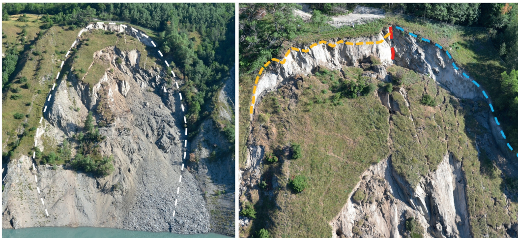
Figure 2.17 – Le glissement de la Berche au 21 juillet 2015 © EDF-DI-TEGG
