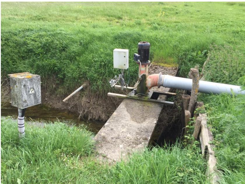
Figure 6. Sortie de drainage dans un fossé tertiaire avec pompage dans un fossé secondaire, sur le site expérimental de Saint Laurent de la Prée (photo prise le 27/04/2018)
