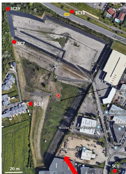
FIGURE 31 : VUE AÉRIENNE DU BASSIN D'INFILTRATION DE DJANGO-REINHARDT (CHASSIEU) AVEC LA LOCALISATION DES PIÉZOMÈTRES UTILISÉS POUR LA MODÉLISATION 3D. LA FLÈCHE ROUGE INDIQUE LE SENS D'ÉCOULEMENT DE LA NAPPE.
