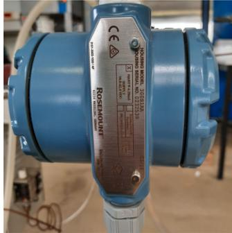
FIGURE II.4 – Transmetteur de pression différentiel modèle Rosemount 3051C.
