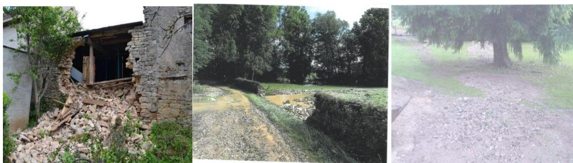
Illustration des étapes d'accumulation – rupture et de dépôt - De gauche à droite : Mur de grange écroulé par la poussée de l'eau venue de l'amont ; Mur de ceinture d'une propriété écroulé sous l'effet de l'accumulation d'eau de ruissellement ; Dépôt de matériaux grossiers dans un jardin.
