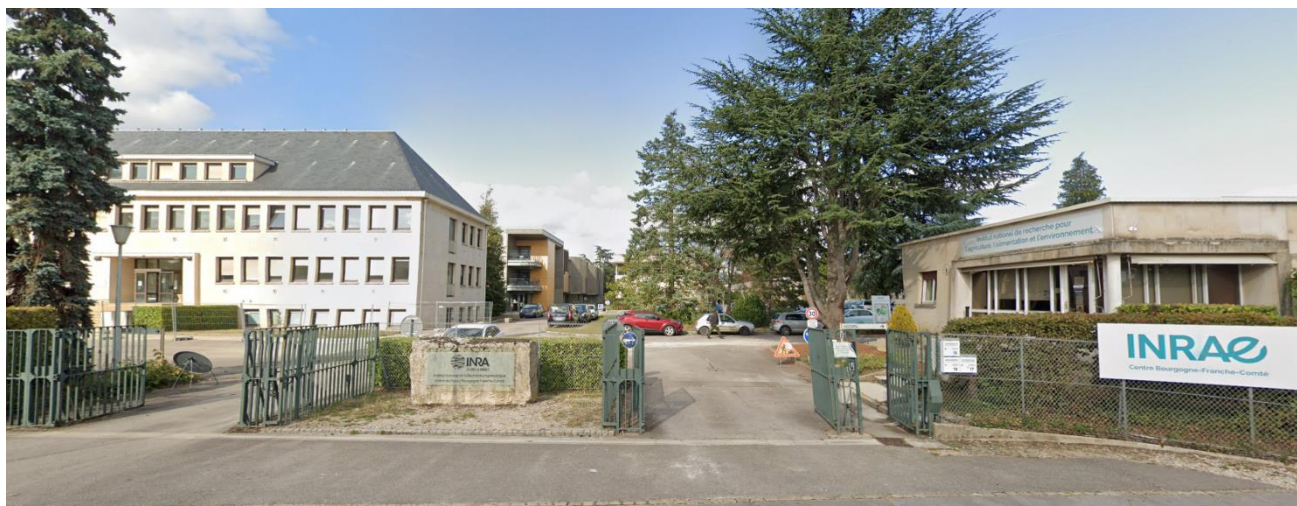
Figure 2 : Entrée et devantures des bâtiments de l'INRAE de Dijon.
