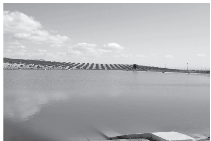
Fig. 5 - HDPE geomembrane installed in La Mericana reservoir (Jarandilla de la Vera-Cáceres-Spain) Courtesy M. Blanco.
