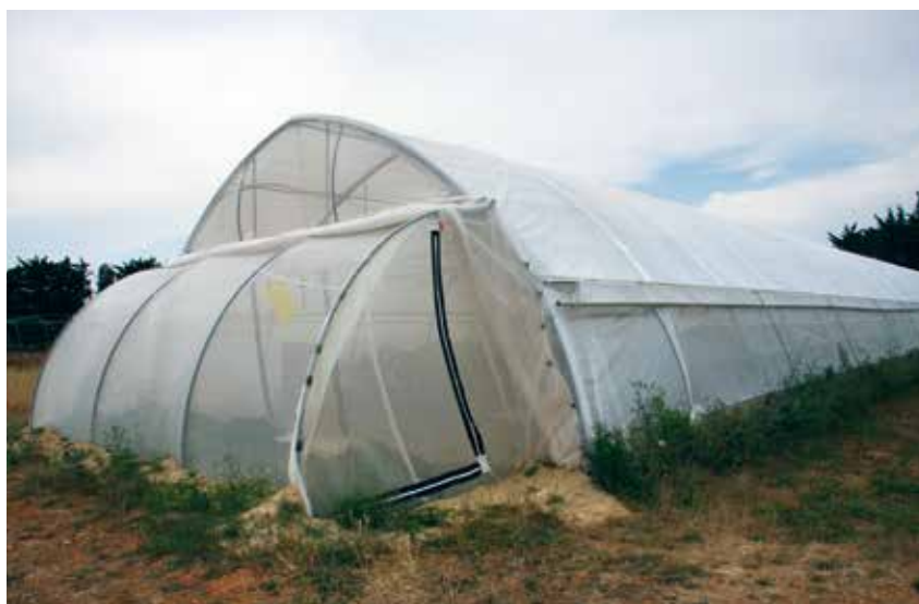
> PHOTO 12 : TUNNEL 8 M À AÉRATION PAR RELEVAGE LATÉRAL ÉQUIPÉ D'UN FILET INSECT-PROOF (TIP1000, TEXINOV) SUR LES OUVRANTS ET D'UN SAS DEVANT LA PORTE SUR LE CENTRE CTIFL DE BALANDRAN
