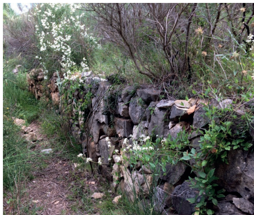
Figure 6. Murets de pierre sèche en zone C.
