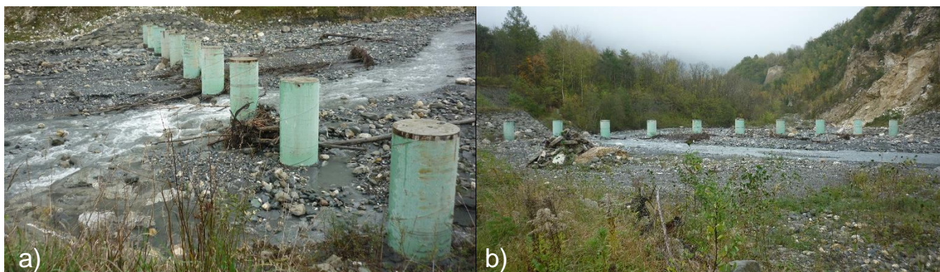
Figure 8 : Vue de l'ouvrage en Octobre 2014 : a) depuis la rive gauche et b) depuis l'amont
