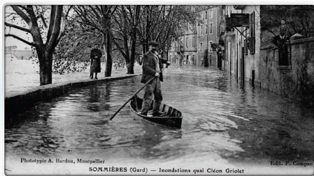
Figure 1 : Crue de 1907 à Sommières (Source : Mairie de Sommières)
