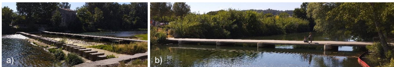
Figure 3 : Passerelles submersibles de la traversée de Sommières
