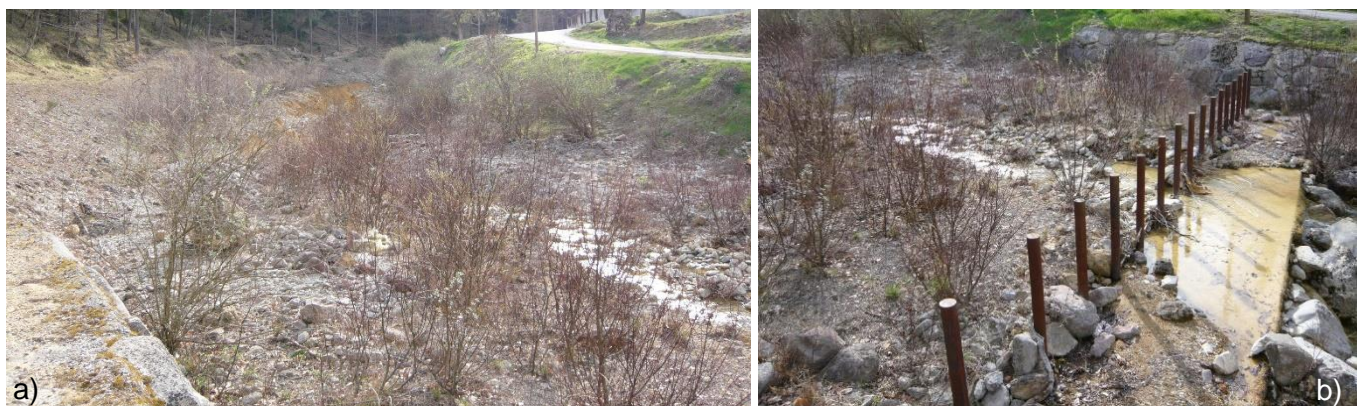
Figure 6 : Photographies de l'ouvrage en 2008 (Source : ONF-RTM 06) : a) plage de dépôt amont et b) piège à flottants. Les dépôts sédimentaires étaient en cours de végétalisation et le chenal creusé par incision avant 2002 est toujours visible au second plan. L'ouvrage ne semble pas avoir subi de crues majeures ni aucune opération d'entretien significative.
