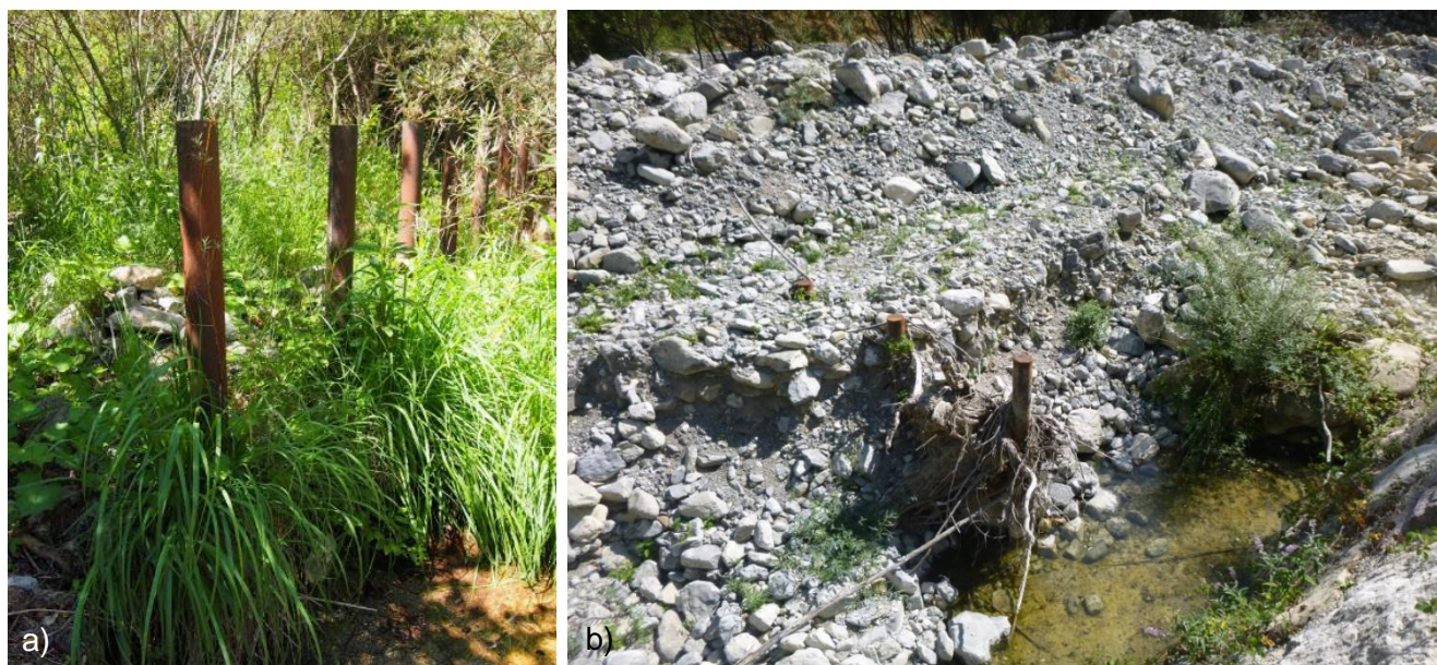
Figure 7 : a) Photographie du piège à flottants des Imberts en 2018 et b) photographie de la plage de dépôts suite au comblement associé à la tempête Alex en 2020 et réapparition de pieux enterrés (Source ONF-RTM DRN et : ONF-RTM 06)
