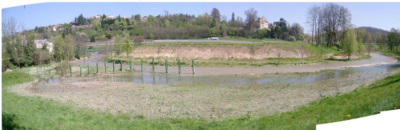
Figure 4 : Piège à flottants de Bourgoin-Jallieu vu depuis l'amont avant plantation des berges (source : SMABB, 2019)
