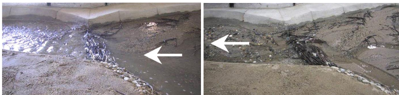
Figure 9 : Etude de l'ouvrage sur modèle physique : a) accumulation de flottants contre l'ouvrage et remous liquide associé au pic de crue, b) état du lit après la crue (source : Kouliniski et Richard, 2008)
