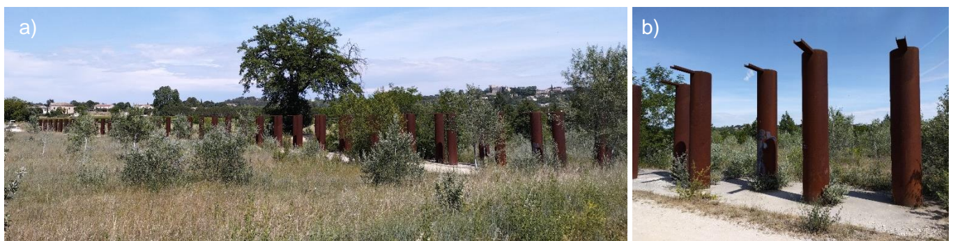
Figure 7 : Piège à flottants à l'amont de Sommières : a) vue d'amont et b) vue de près sur les pieux
