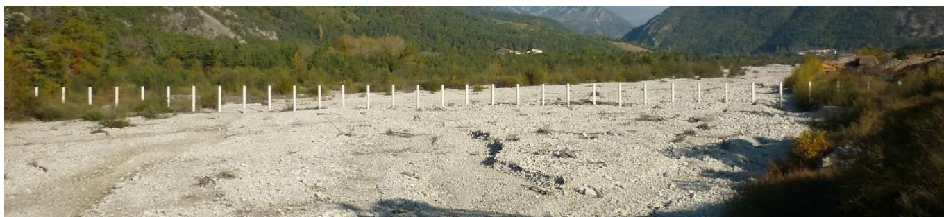
Figure 3 : Ouvrage vue de l'aval depuis le pont de la RD994 en 2015
