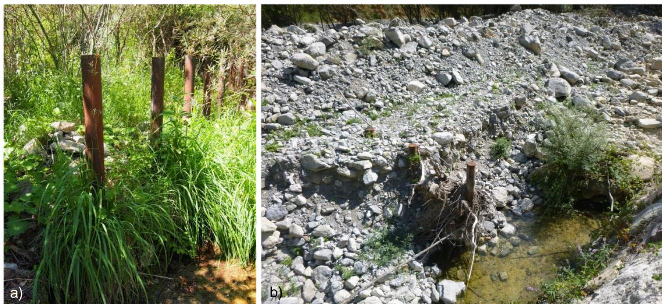
Figure 7 : a) Photographie du piège à flottants des Imberts en 2018 et b) photographie de la plage de dépôts suite au comblement associé à la tempête Alex en 2020 et réapparition de pieux enterrés (Source ONF-RTM DRN et : ONF-RTM 06)
