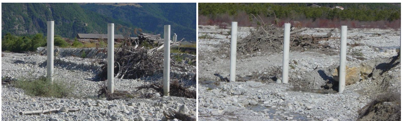
Figure 7 : Accumulations de bois flottants retirées du piège suite à la crue de décembre 2009 et mise en dépôt sous forme de tas en attente d'évacuation (source : ONFR-RTM 05, 2010).
