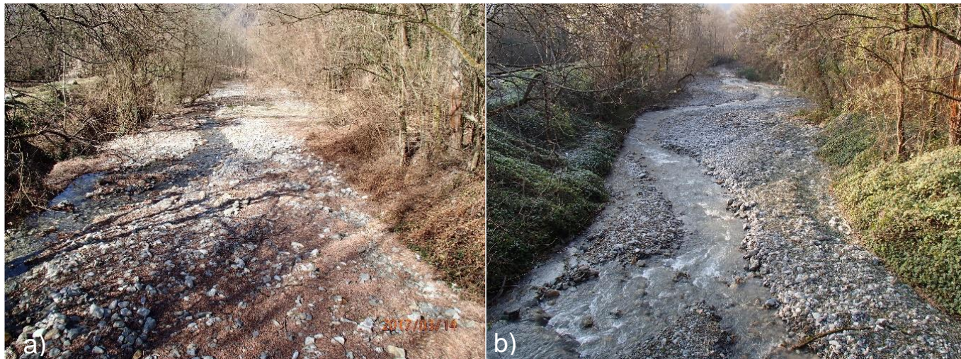
Figure 2 : Engravement du lit de la Balme entre fin 2013 et début 2017 à l'aval du pont de la route communale, fortement lié à la crue de Mai 2015 (source : ONF-RTM 73, 2020)
