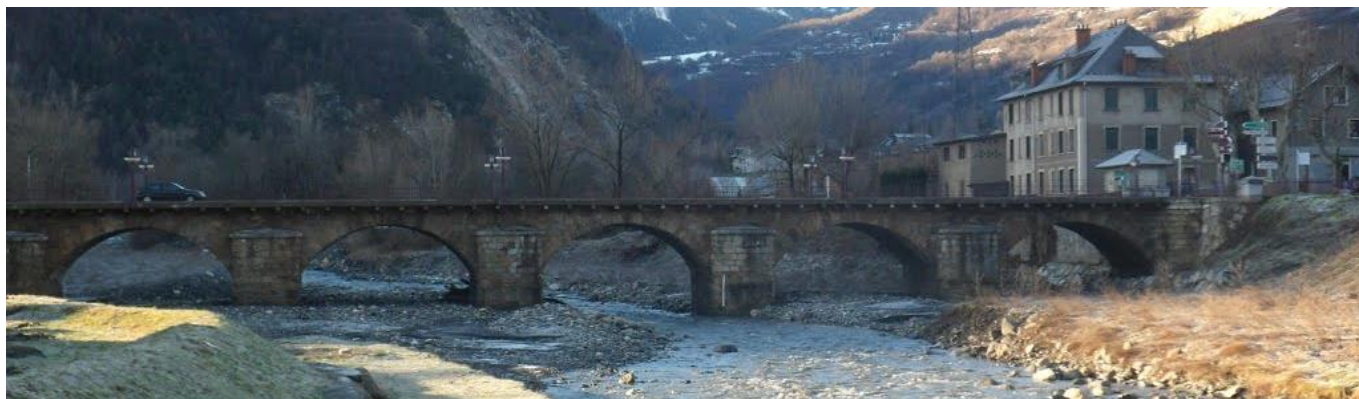
Figure 2 : Pont d'Arvan de la RD906 vu depuis l'aval (source : mapio.net)
