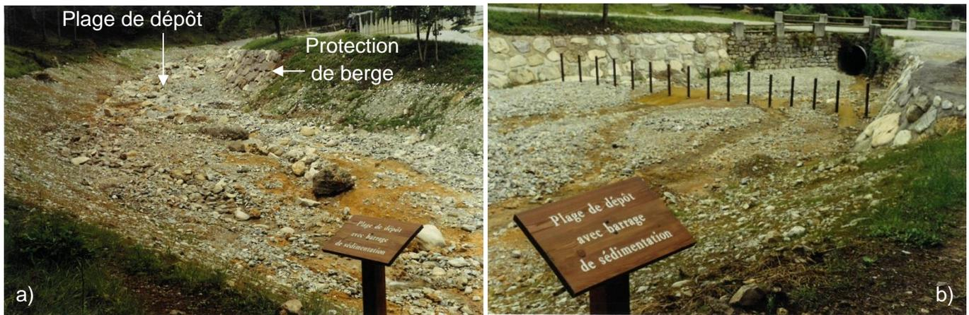
Figure 4 : Photographies du piège à flottants de Rochebillière lors de sa construction en 1997 – a) vue vers l'amont et la plage de dépôt. Une protection de berge a été mise en œuvre en rive gauche de la plage de dépôt pour protéger la route du cimetière. b) vue vers l'aval, le piège à flottant et la buse à protéger en aval. Les berges autour du râtelier ont aussi été protégées contre les érosions par des encochements liaisonnés au béton (Source : ONF-RTM 06)
