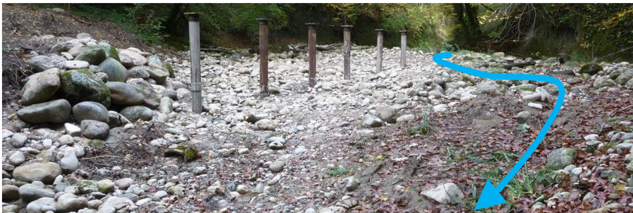
Figure 3 : Etat de l'ouvrage à la fin des travaux, le tracé bleu indiquant la direction de l'écoulement (Source : ONF-RTM 73, 2018)
