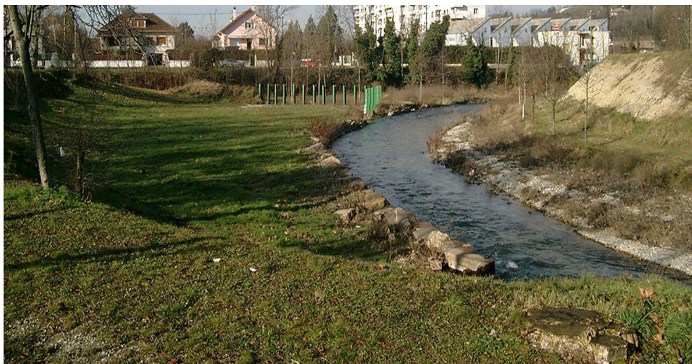
Figure 6 : Photographie du piège à flottants de Bourgoin-Jallieu vu depuis la berge gauche (source : SMABB, 2019)
