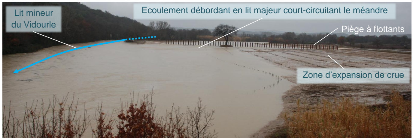
Figure 8 : Vue générale de l'aménagement depuis le viaduc situé en aval, crue de Février 2009 (source : EPTB Vidourle)
