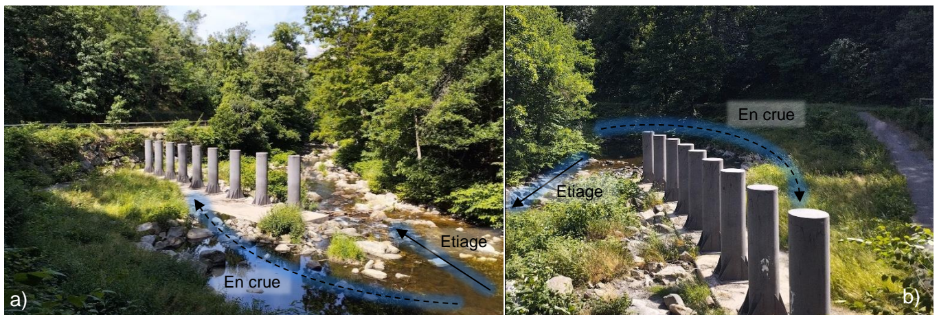
Figure 5 : Photographies du piège à flottants en Mai 2022 vu a) depuis l'amont et b) depuis l'aval
