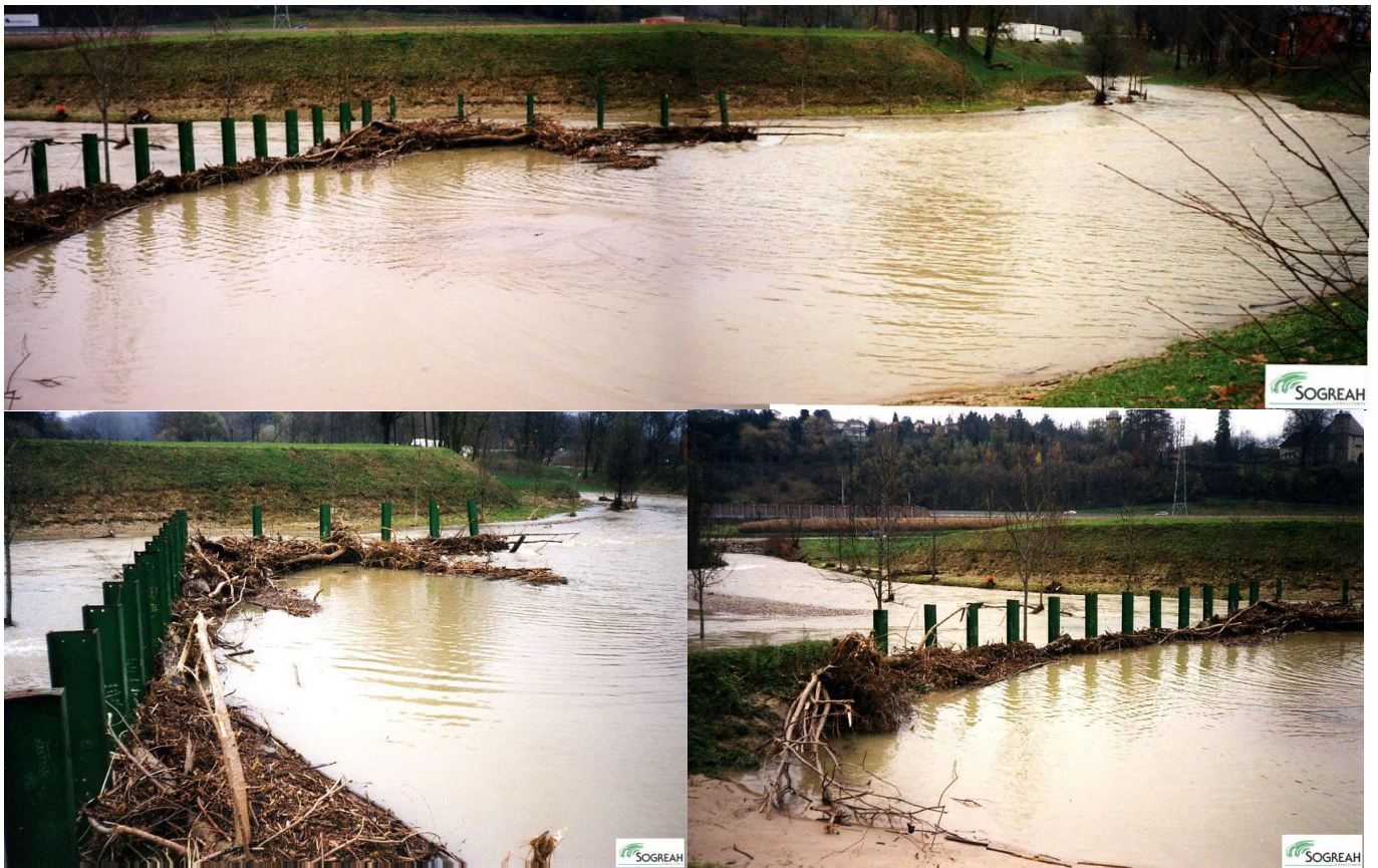
Figure 7 : Photographies du piège en fonctionnement pendant la crue de Novembre 2002 (source : archives SOGREAH)
