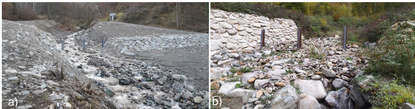
Figure 3 : Piège à flottant vu d'aval a) à la fin des travaux (source : Syndicat du Pays de Maurienne, 2020) et b) en Octobre 2022
