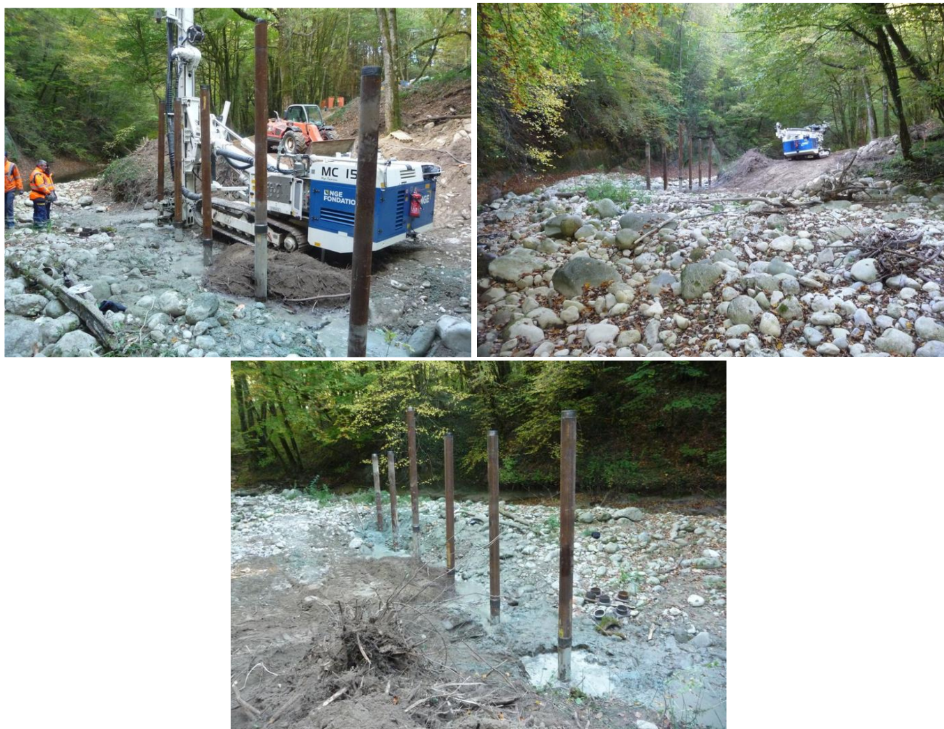
Figure 5 : Photographies des travaux (Source : ONF-RTM 73, 2018)
