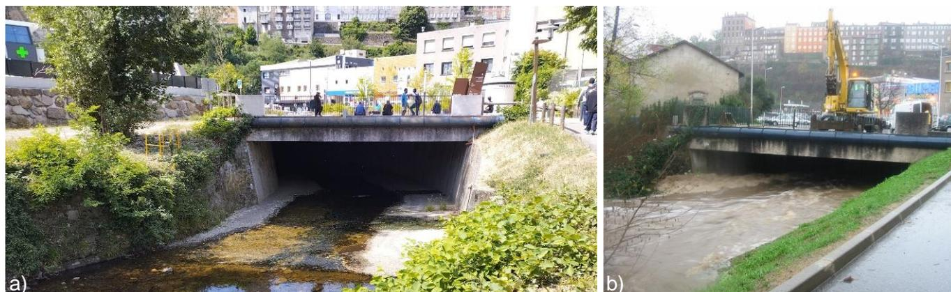
Figure 1 : Amont du passage couvert de la Déûme à travers le centre-ville d'Annonay : a) à l'étiage en Mai 2022 ; b) lors d'une crue de période de retour sensiblement vingtennale le 02/12/2003 (source : Syndicat des 3 Rivières)
