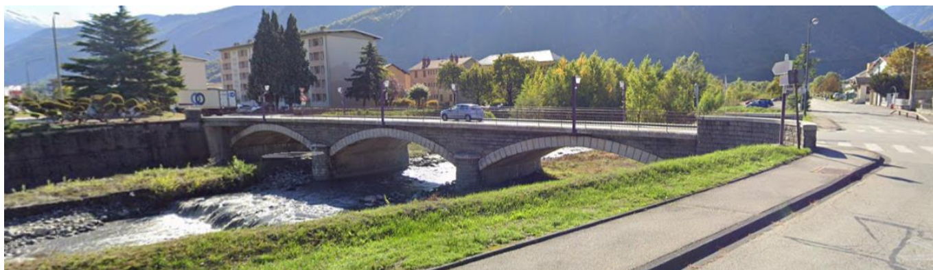
Figure 3 : Pont Cizeron de la RD77 vu depuis l'aval (source : GoogleStreetView)
