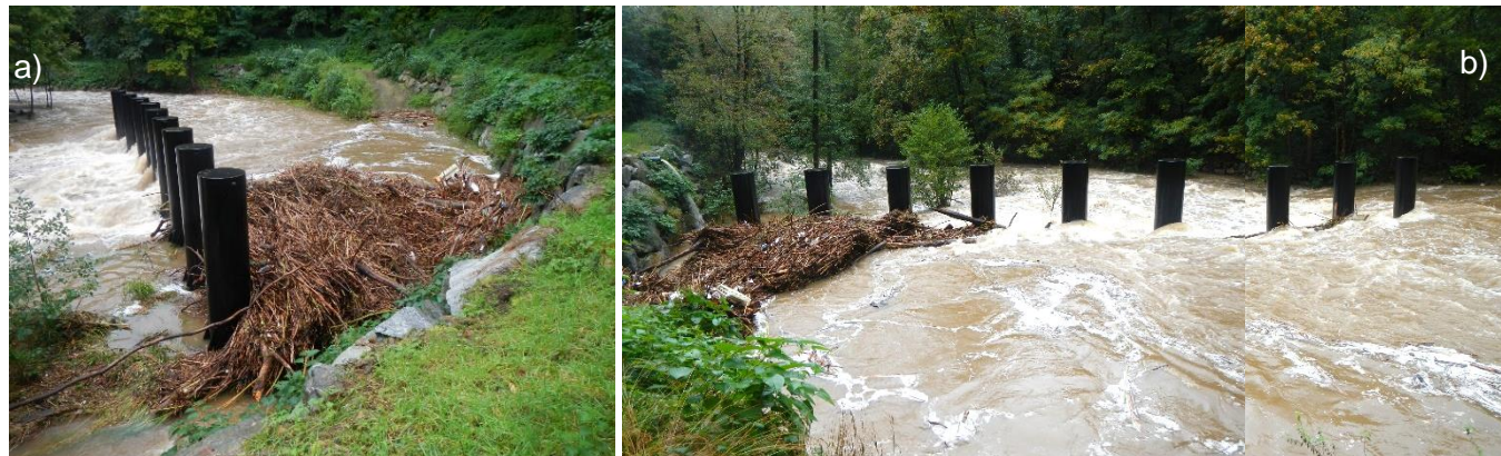
Figure 7 : Crue d'Octobre 2014 : a) vue dans l'axe du râtelier, b) râtelier vue d'amont (source : Syndicat des 3 Rivières). Concentration des flottants contre la rive gauche au fond du piège. Quelques flottants, vraisemblablement de plus grand gabarit peuvent être distingués entre les premiers pieux en rive droite et participe à élever la ligne d'eau en amont de l'ouvrage
