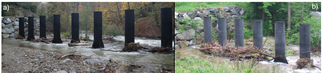
Figure 6 : Photographies de début de piégeage de petit bois : a) crue du 3 novembre 2010 et b) crue du 18 mai 2013 (source : Syndicat des 3 Rivières). Arrêt de branches et petit bois contre les pieux, début de blocage de plus gros éléments entre les pieux.
