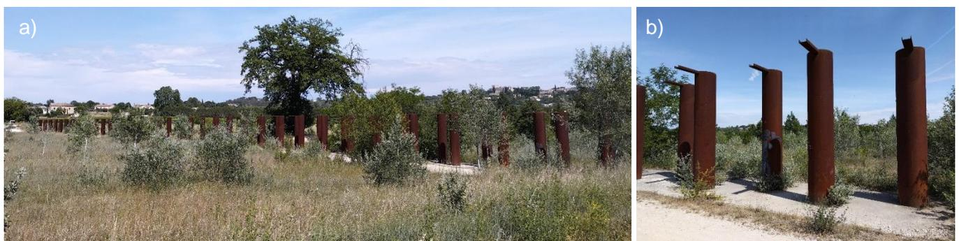
Figure 7 : Piège à flottants à l'amont de Sommières : a) vue d'amont et b) vue de près sur les pieux
