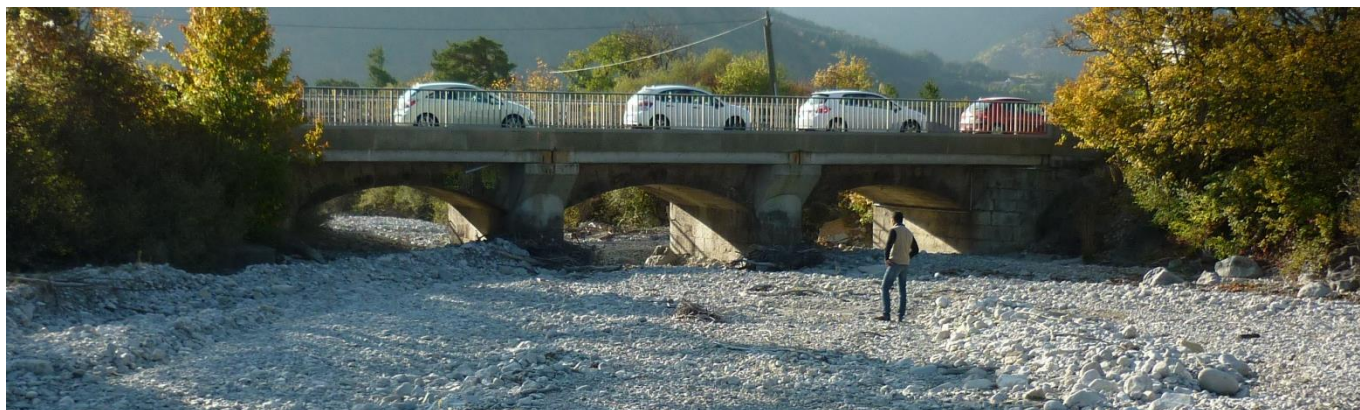
Figure 2 : Vue d'amont du pont de la RD994
