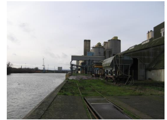
Port fluvial céréalier de Metz sur la Moselle canalisée Photo : L. de La Haye Saint Hilaire, ASTER, 01-2021
