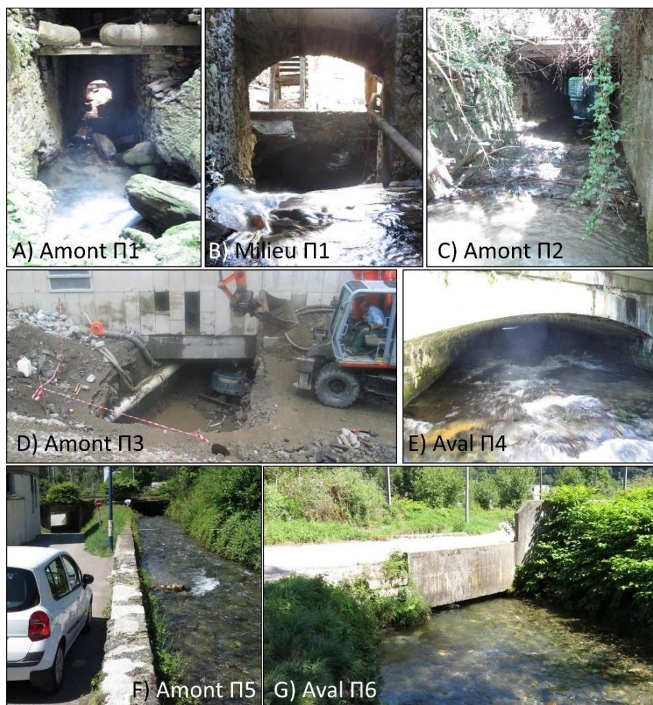
Figure 14 : Photos des ouvrages de couvertures
