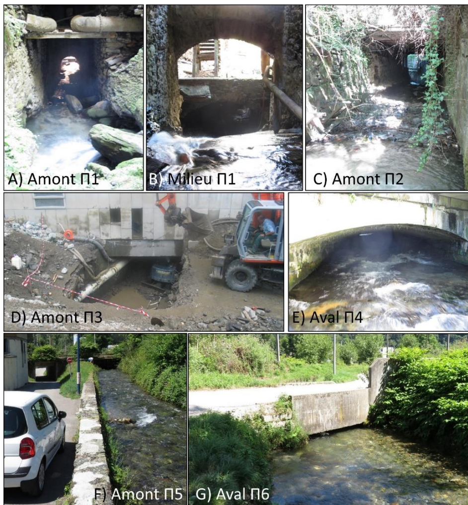
Figure 14 : Photos des ouvrages de couvertures
