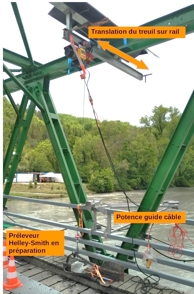
Figure 1 : Dispositif de déploiement par treuil sur la verticale centrale du pont de Pyrimont
