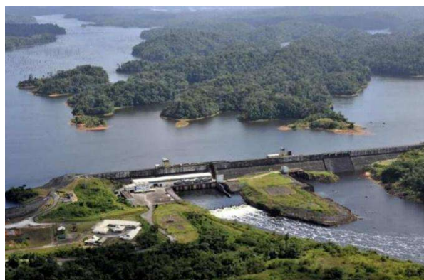
Figure 36 : Photographie aérienne du barrage de Petit-Saut (Vigouroux, 2016)
